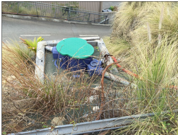
Vue sur le séparateur à Hydrocarbures installé à l'entrée du site
