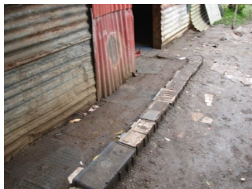
Seuil de porte en accumulateurs au plomb
