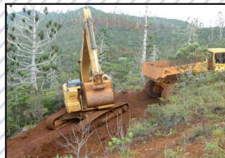
Photo 1 - Décaissement des talus à la pelle et transport des déblais par camions
