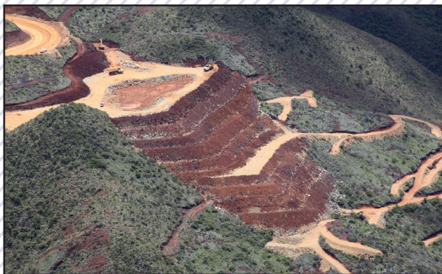
Photo 7 - Protection frontale en enrochement d'une verse à stériles miniers
