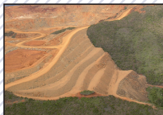
Photo 7 - Protection frontale en enrochement d'une verse à stériles miniers
