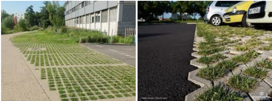
Figure 44 : Exemple de parkings en dalles béton avec remplissage végétal
