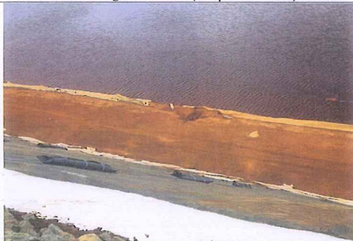
Photo 9 : figure d'érosion (banquette 220.Sud)
