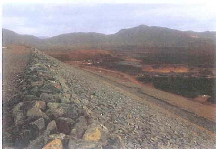
Photo 13 : parement aval berme
