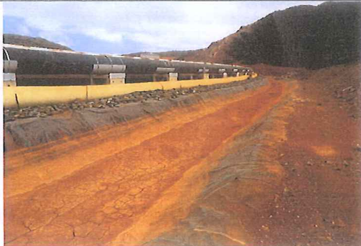
Photo 30 : drain de dérivation Nord (section intermédiaire)
