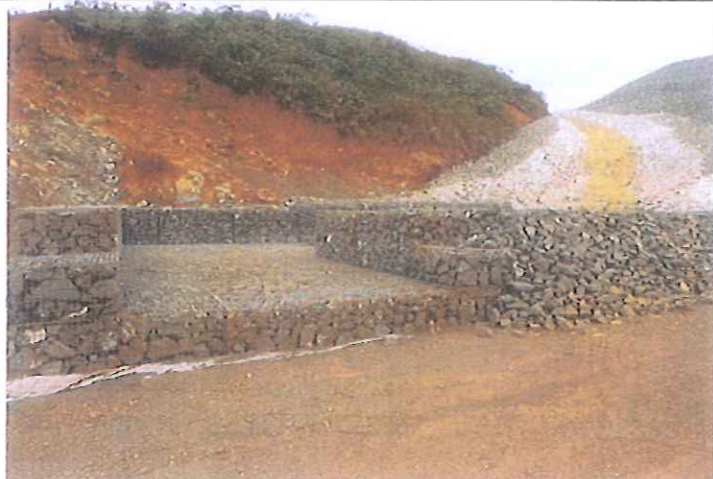
Photo 25 : by-pass exutoire drain de dérivation Sud
