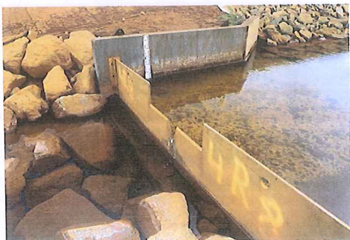
Photo 23 : déversoir drain de pied 4R8
