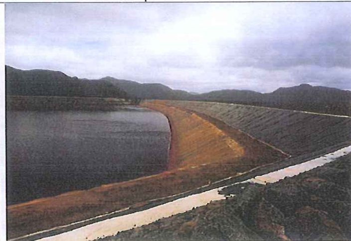
Photo 12 : parement amont berme
