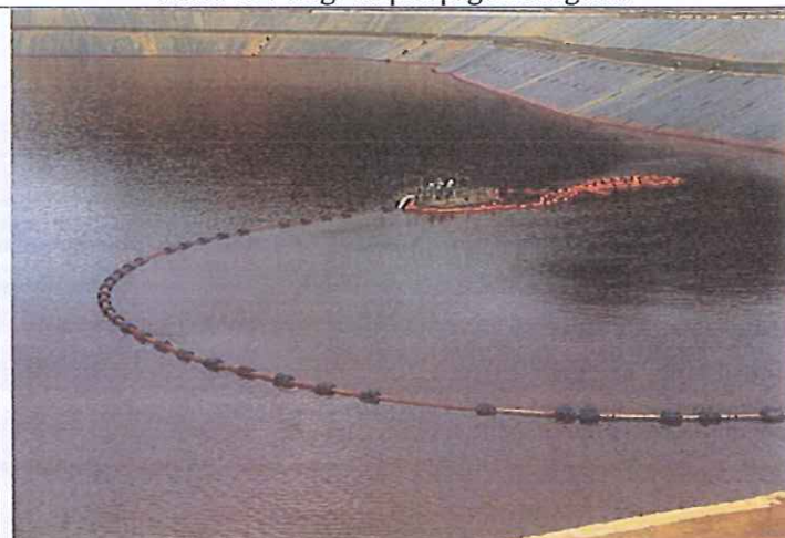
Photo 18 : barge de pompage surnageant
