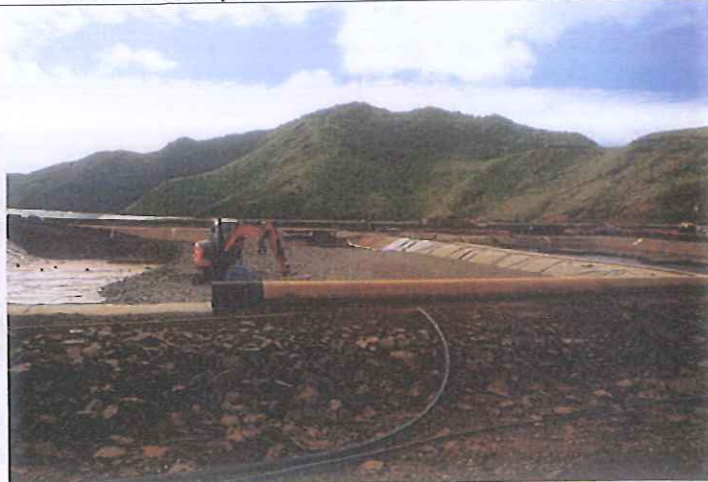
Photo 2 : mise en place couche de drainage (cellule de suivi)
