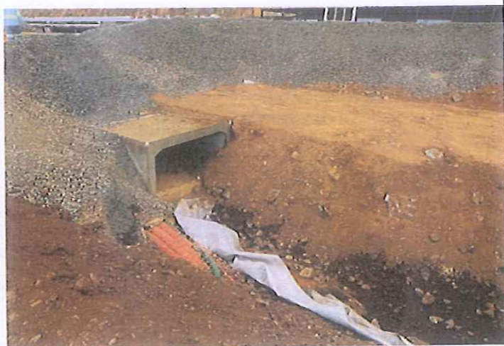
Photo 21 : drain de dérivation appui RG
