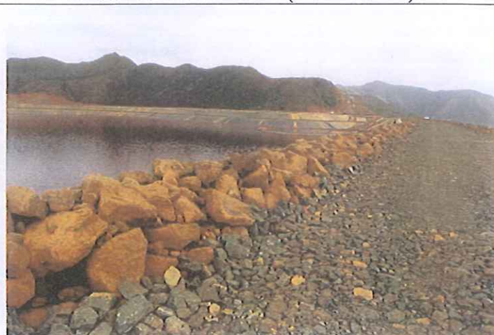
Photo 16 : crête de la berme (merlon rocheux)
