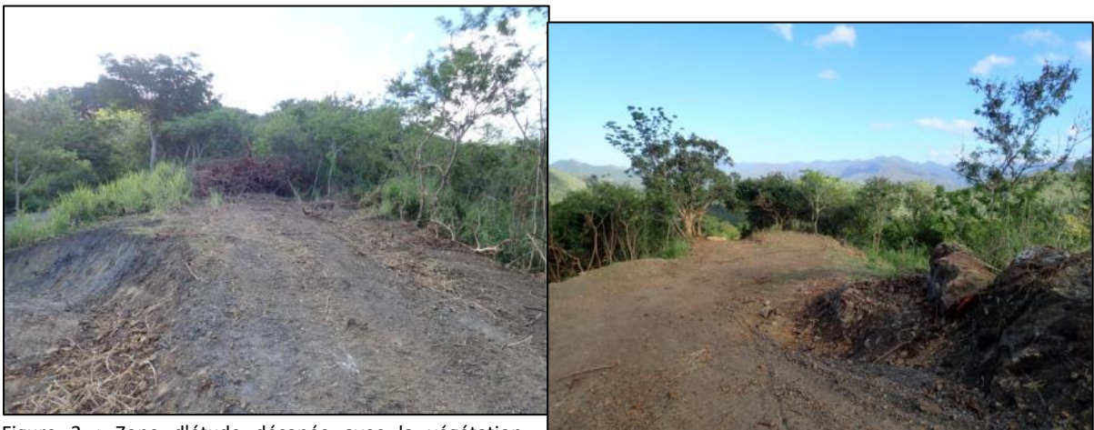
Figure 3 : Zone d'étude décapée avec la végétation environnante.
