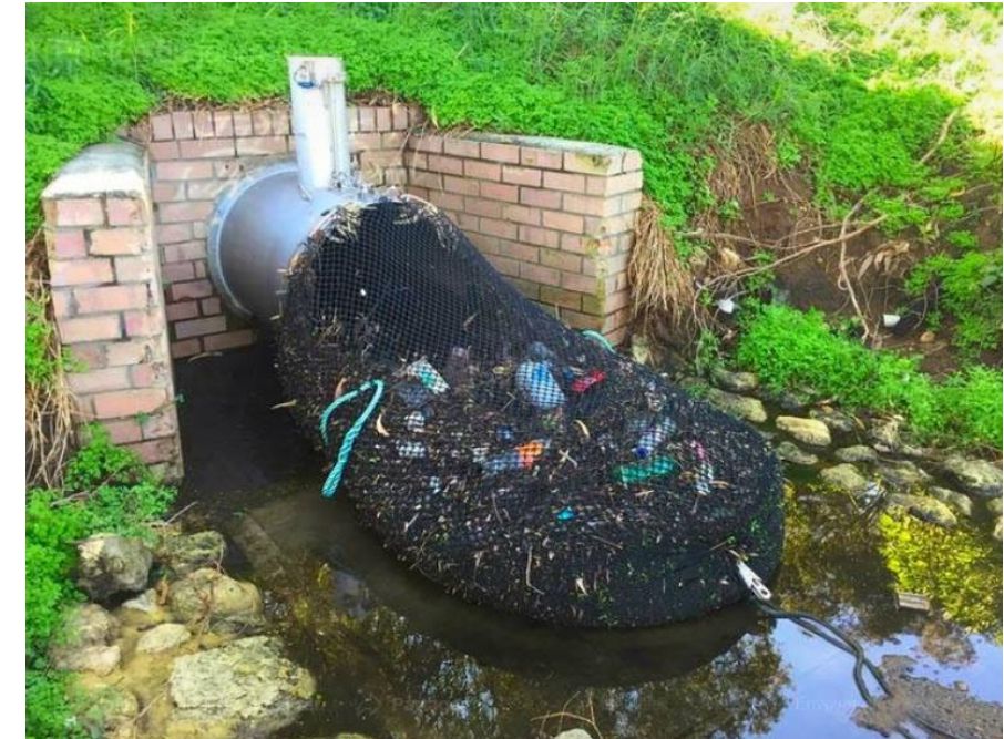
Exemple de filet pouvant être mis en œuvre pour le curage des buses
