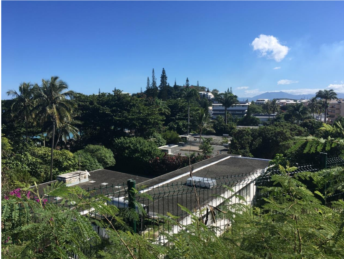
Figure 38 : Vue depuis la colline sur les habitations de la SLN
