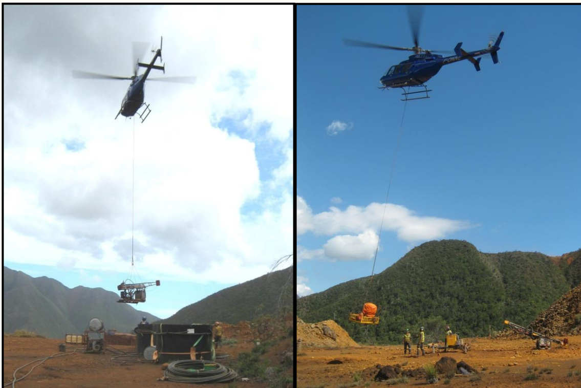
Photo 3 : Déplacement héliporté des sondeuses.
