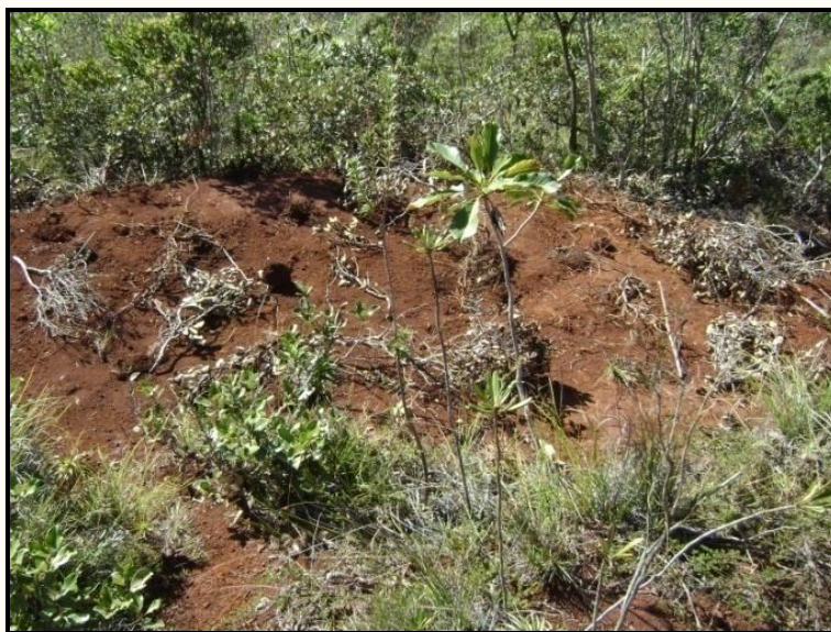
Photo 4 : Top soil remplacé sur une plateforme.
