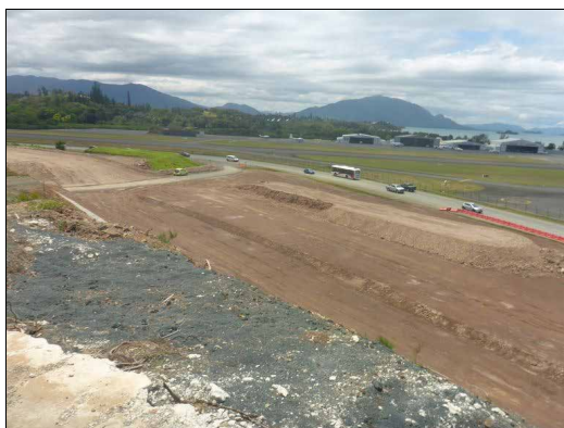
Vue sur le chantier de la RP14
