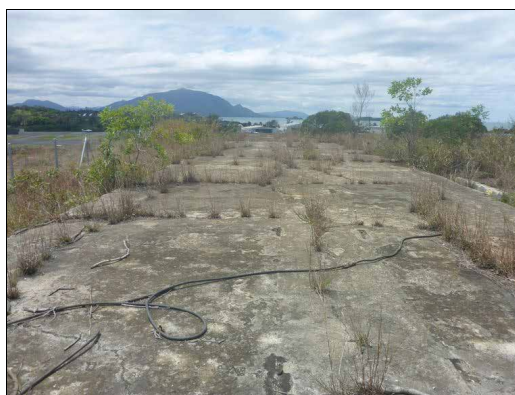
Ancienne dalle en béton sur zone haute de la parcelle
