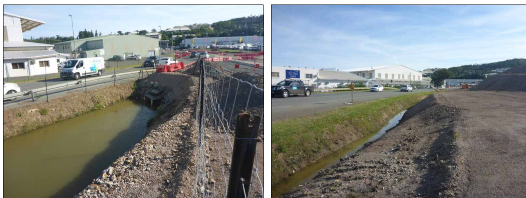
Démarrage du fossé de collecte des eaux au niveau de l'ouvrage-cadre Fossé de collecte des eaux existant
