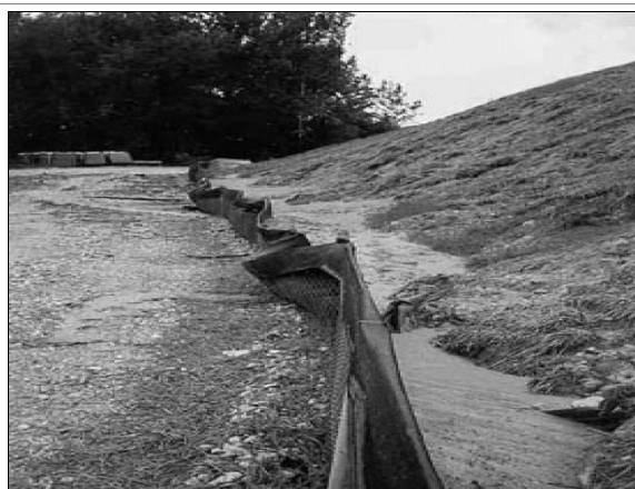
Exemple de barrière sédiments en géotextile pour un stockage de matériaux.
