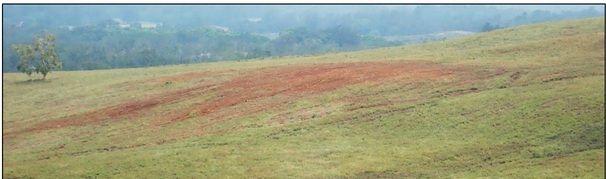
Photo 6 : Erosion de surface sur les zones non recouvertes de végétation.
