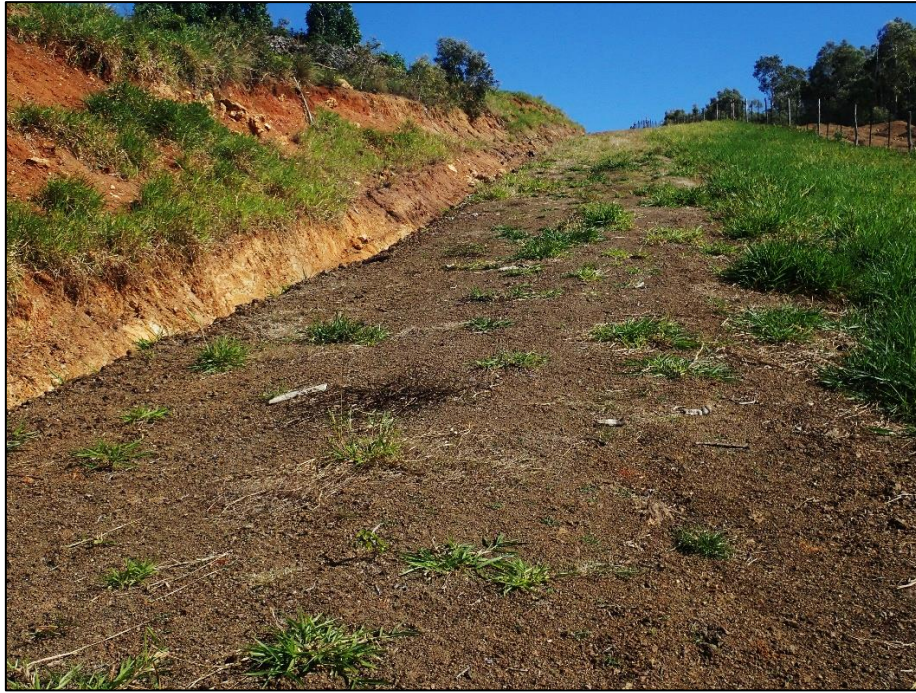
Photo 11 : Gestion des eaux et pralinage des pistes au schiste + ensemencement sur 2,6km.
