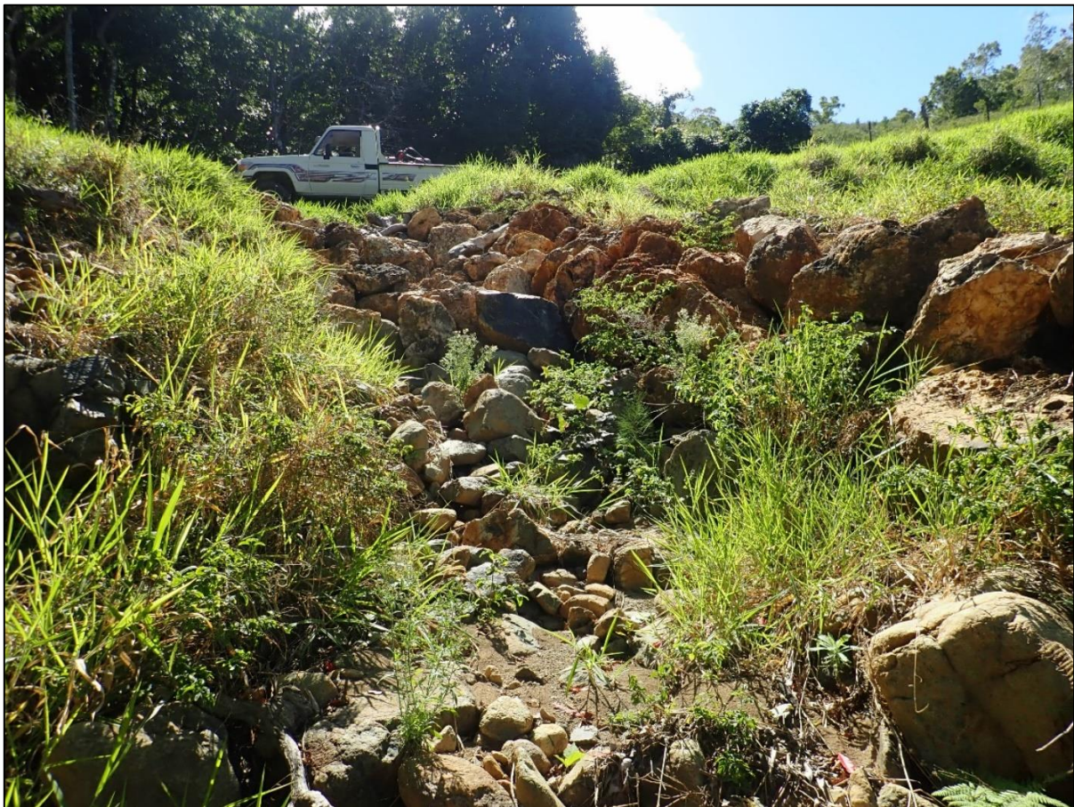
Photo 10 : Exemple d'enrochement au niveau d'un passage d'eau.
