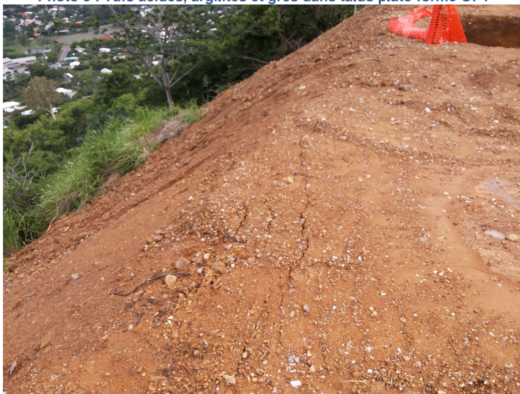
Photo 4 : Fissures de traction en tête des remblais plate-forme OPT
