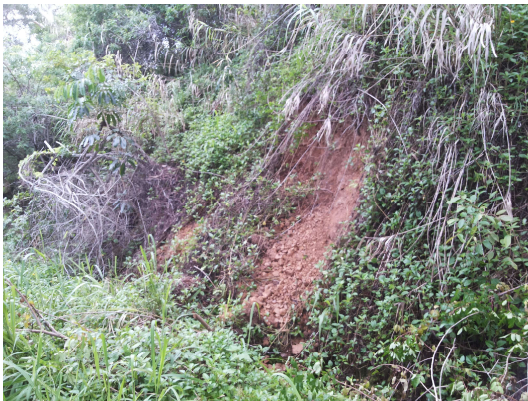
Photo 13 : glissement au niveau du talus de la piste
