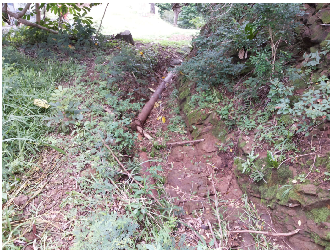
Photo 15 : canalisation dans fossé ancienne piste au niveau de la construction en cours
