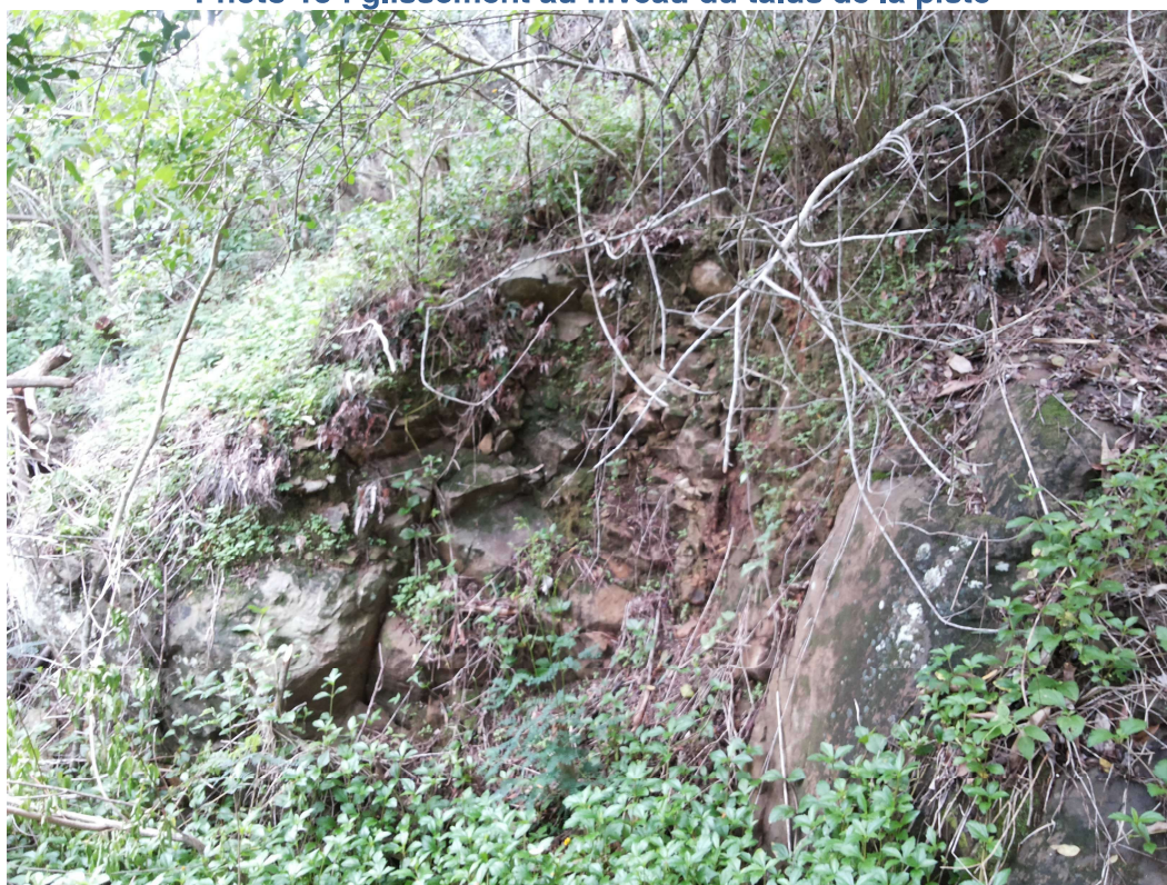
Photo 14 : talus piste ancien écoulement dièdre (grès)
