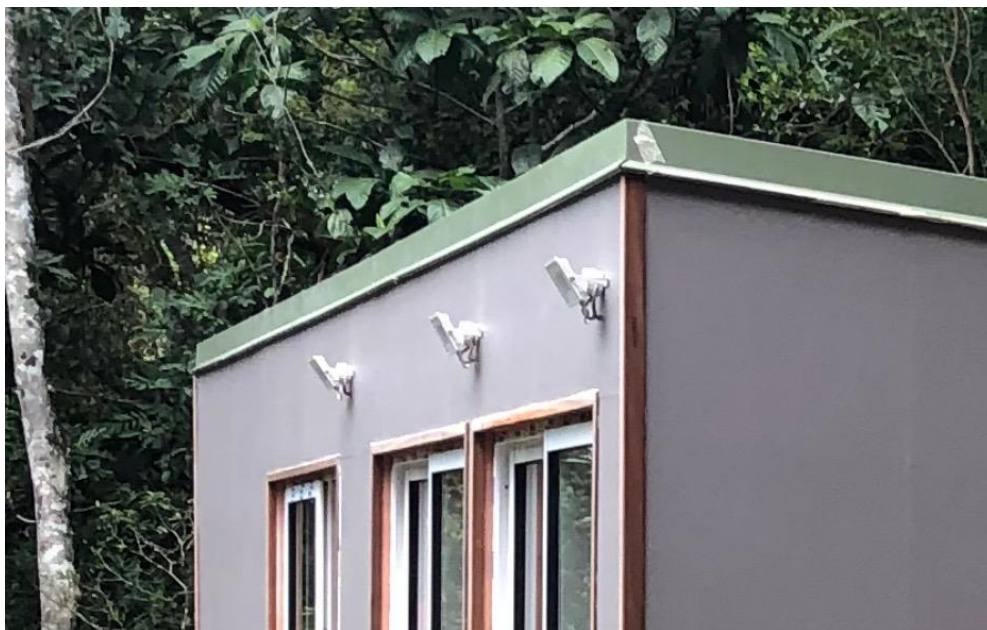
Figure 18 : Modèle de spot LED à détection automatique installé.
