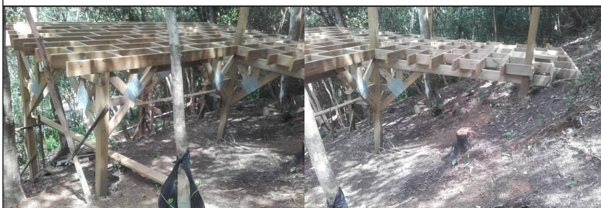
Figure 8 : Dessous de la cuisine. 3 souches coupée + 1 à l'extérieur du deck = 4.
