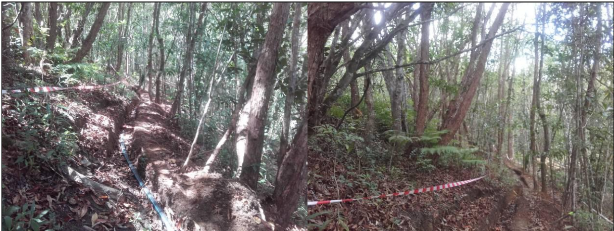
Figure 10 : Le sentier servant à passer les conduites et rallier les différentes plates-formes utilise un ancien sentier existant et n'a nécessité aucune coupe d'arbre supérieur à 10cm de diamètre.
