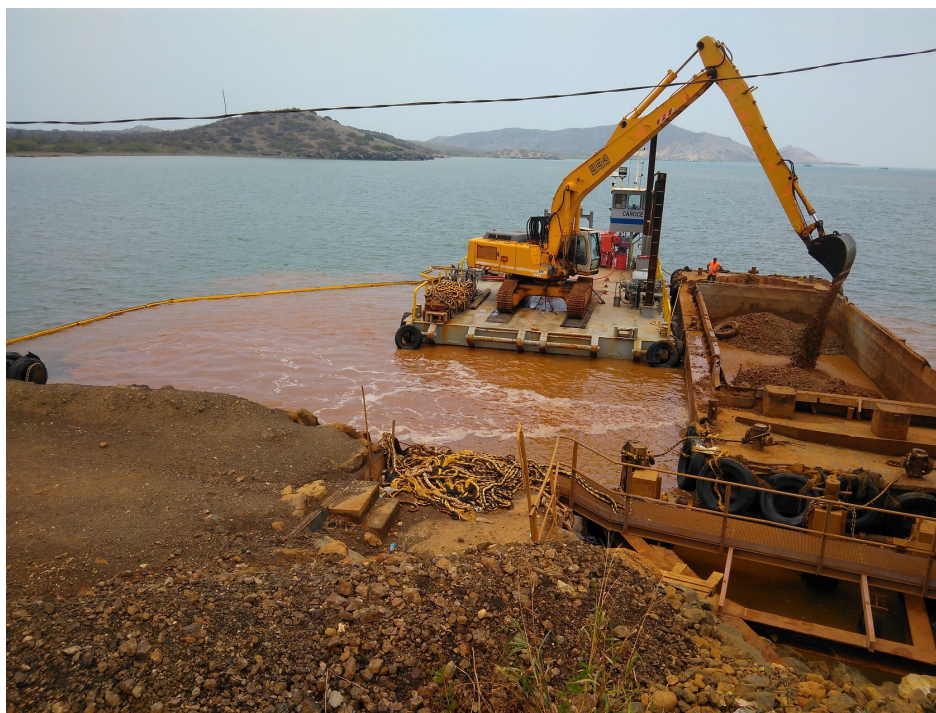
Figure 76 : Barrière anti limon confinant la zone de travail d'une drague mécanique
