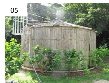
05 Cuve de stockage des eaux traitées
