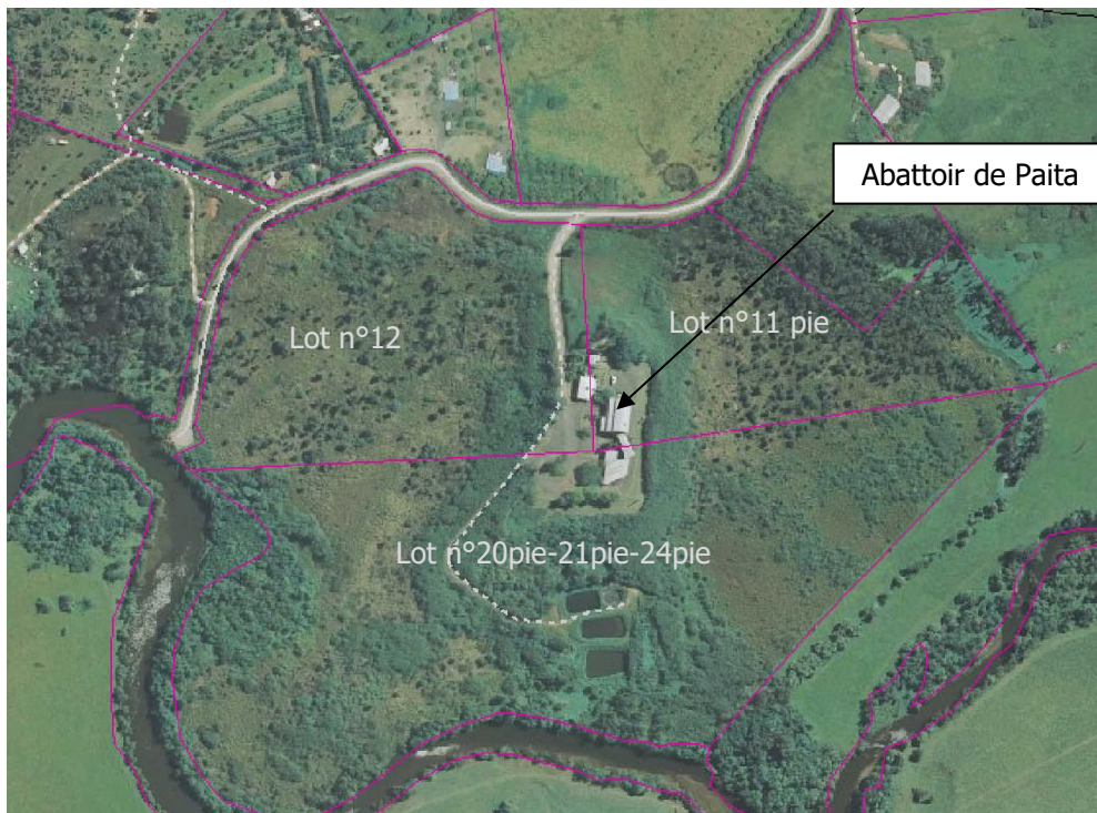
Figure 1 : Vue aérienne du site de l'OCEF (Géorep.nc, sans échelle)
