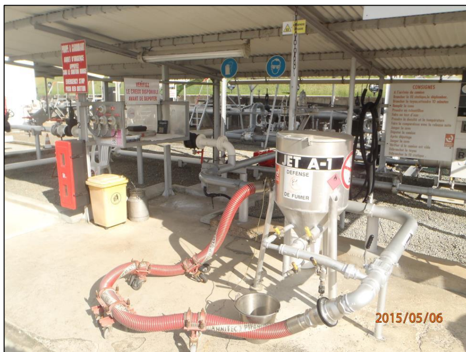
Figure 8 : Pomperie de déchargement de JET A1
