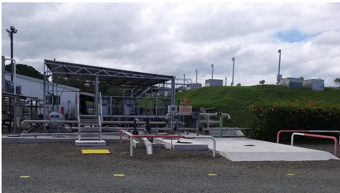
Figure 11 : Pomperie des cuves et de l'hydrant et dalle béton étalon
