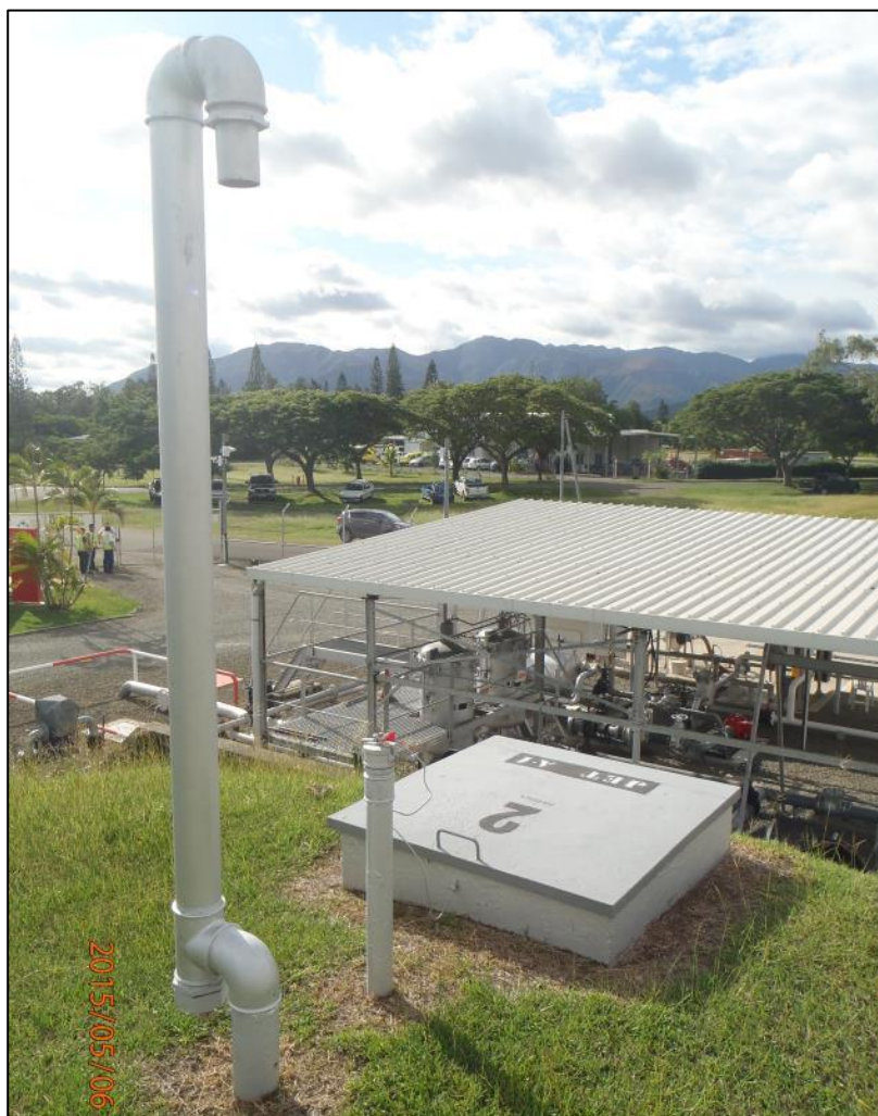
Figure 14 : Event et trou d'homme d'une cuve de JET A1
