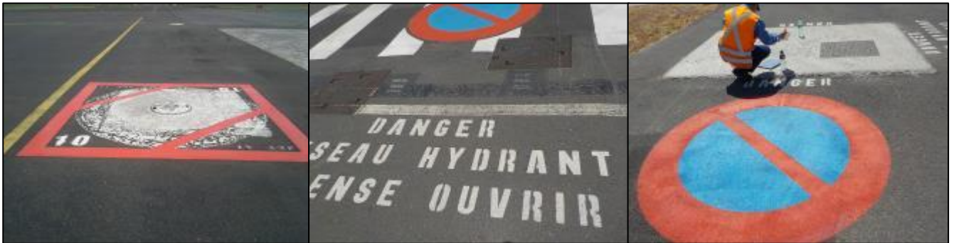
Figure 21 : Affichage de l'hydrant et des pits et regards sur les pistes de l'aéroport
