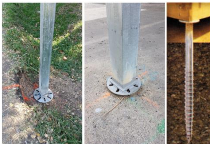
Figure 9 : Illustrations du système de vis de fondation
