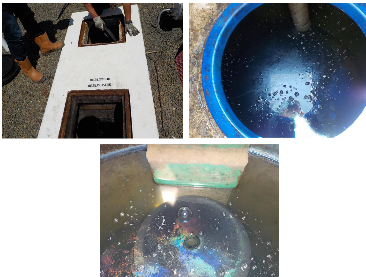
Figure 5 - Débourbeur - Séparateur à hydrocarbures
