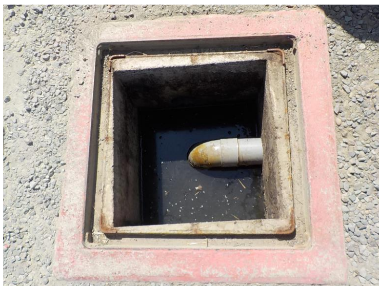
Figure 3 – Regard de collecte des eaux pluviales de l'aire de dépotage
