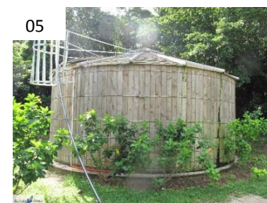
05 Cuve de stockage des eaux traitées
