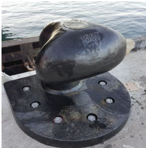
Figure 1 : Exemple de bollard d'amarrage
