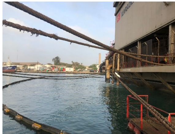
Figure 27 : Mise en place d'un boudin flottant anti-pollution (KPS)
