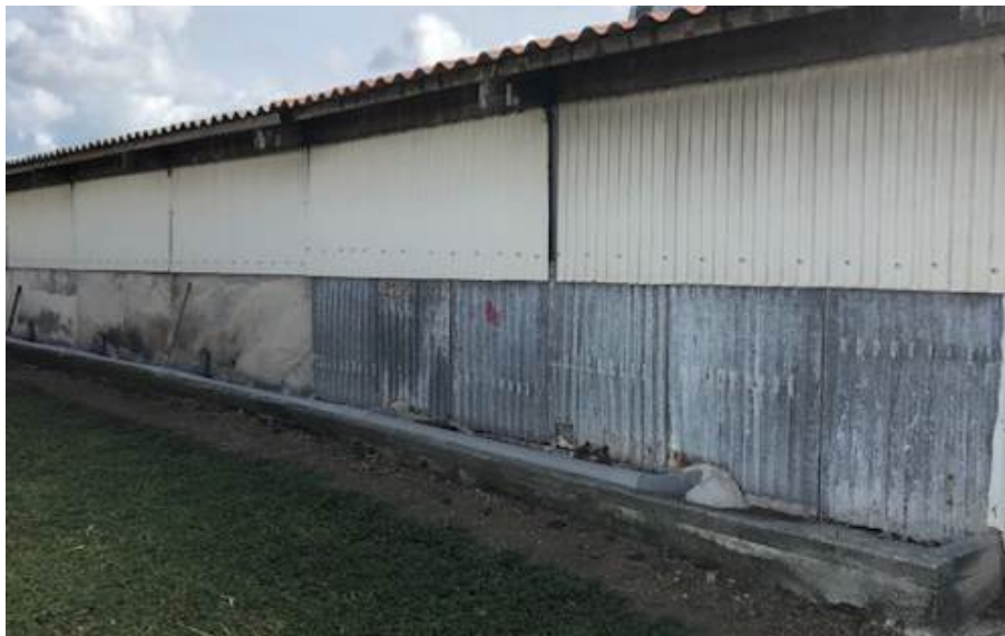
Caniveau de collecte des lisiers (bâtiment post-sevrage)
