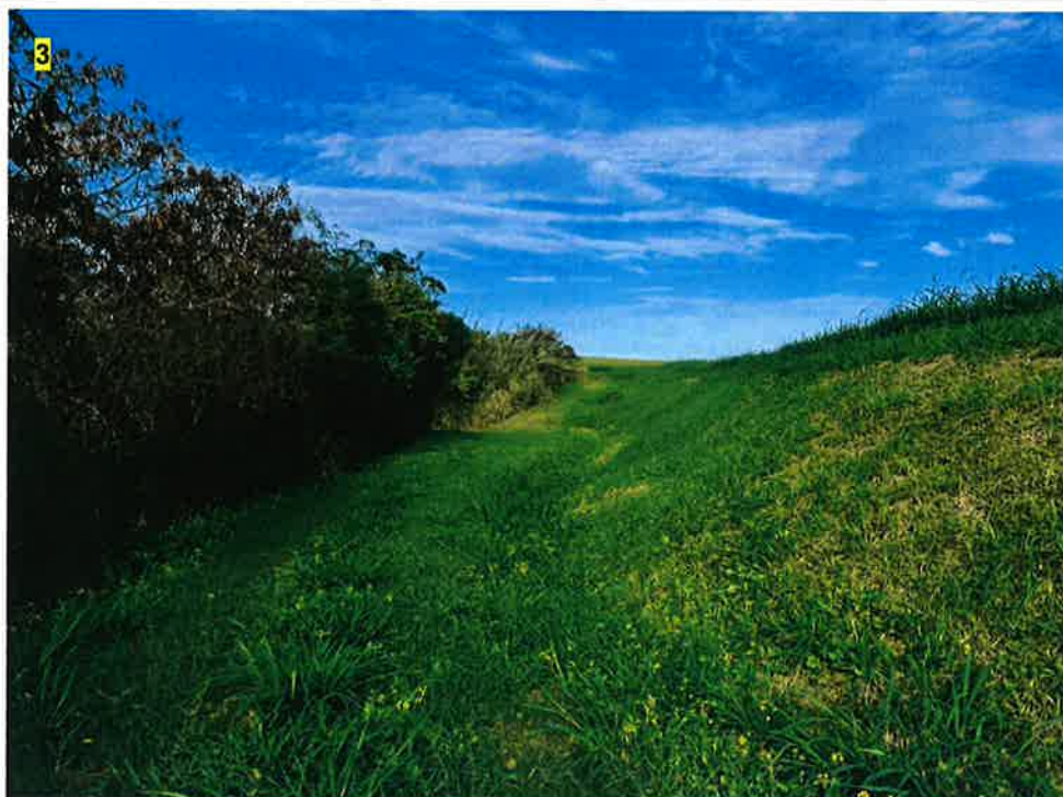
Figure 20 : Photographie 3 – Piste et végétation au niveau du dôme
