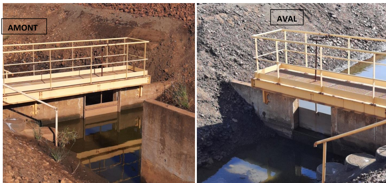
Figure 12: Photographie de la vanne guillotine du point de rejet E4, point où est mesuré le niveau permettant de calculer le débit.
