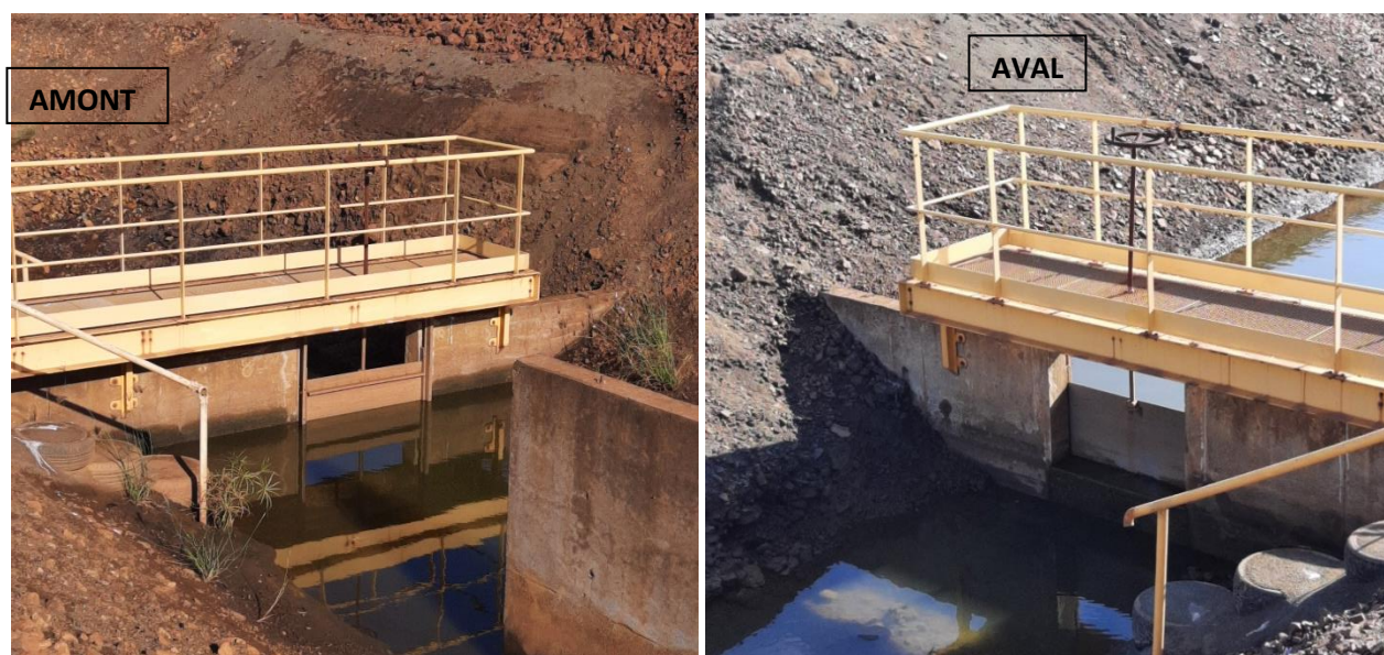
Figure 4: Photographie de la vanne guillotine du point de rejet E4, point où est mesuré le niveau permettant de calculer le débit.
