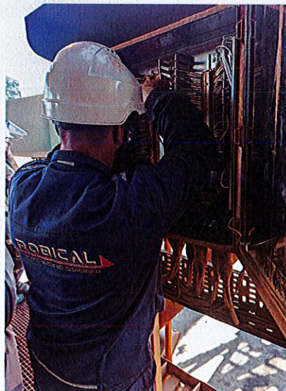
Photo n° 2 : Technicien simulant une augmentation de la température au niveau des sondes
