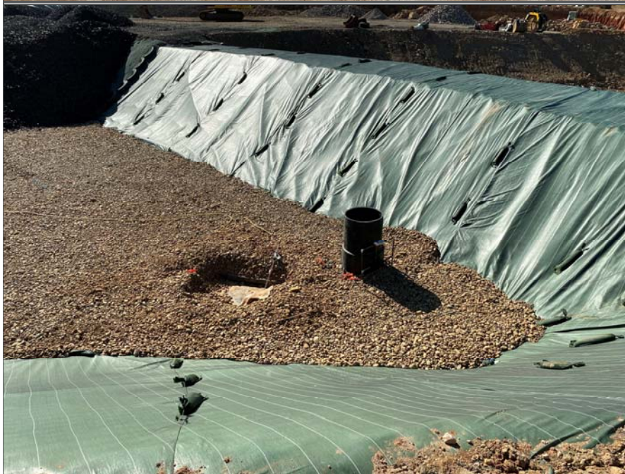
Photo 36: Suspicion de fuite au point bas, à proximité du regard de pompage de lixiviats.
