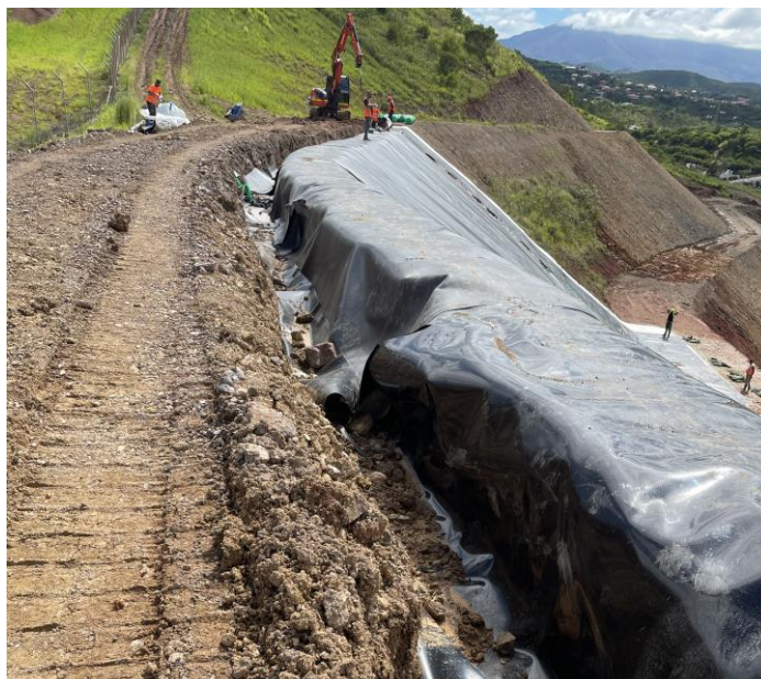
Figure 18 : Photos des tranchées d'ancrage du DEG en tête des talus supérieurs
