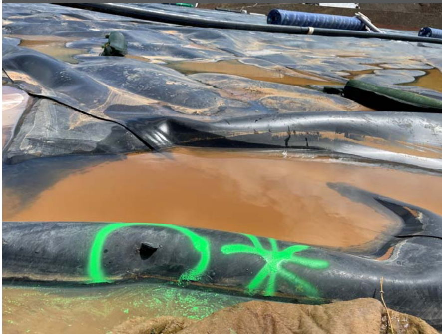
Photo 30: Perforation détectée dans le coin Sud-Ouest du casier à la jonction avec l'ancien casier.
