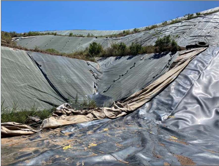
Photo 27 : Angle Nord-Ouest du casier E2 à la jonction avec l'ancien casier. La prospection est rendue impossible par la présence de sol. La prospection au dipôle sera favorisée ici.
