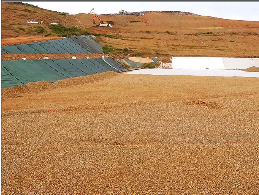
Photo 32: Massif de galet recouvrant la géomembrane sur 30 cm d'épaisseur avant de placer les pneus déchiquetés (20 cm)
