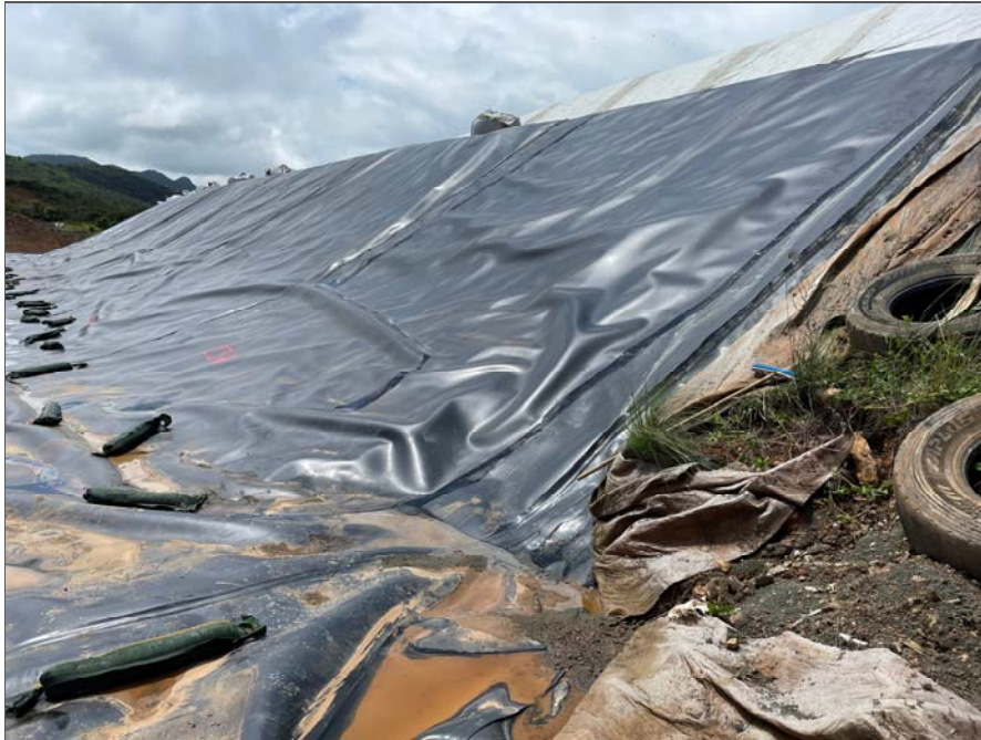
Photo 25 : Zone de jonction entre l'ancien casier et la risberne sud. Présence de lixiviats rendant plus difficile la prospection (nécessité d'éponger)
