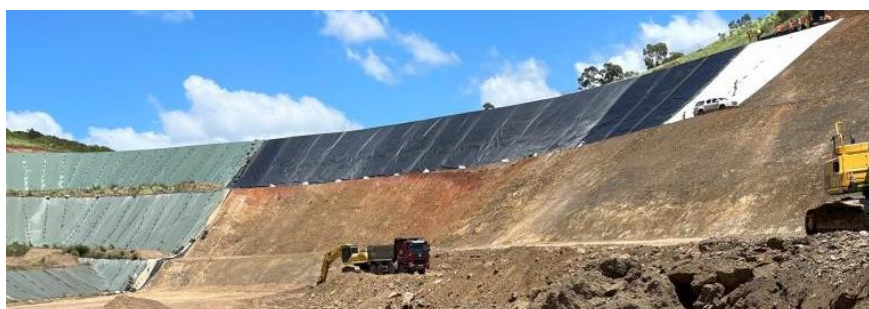
Figure 9 : Talus Haut : Géomembrane (noire) sur GSB (blanc)
