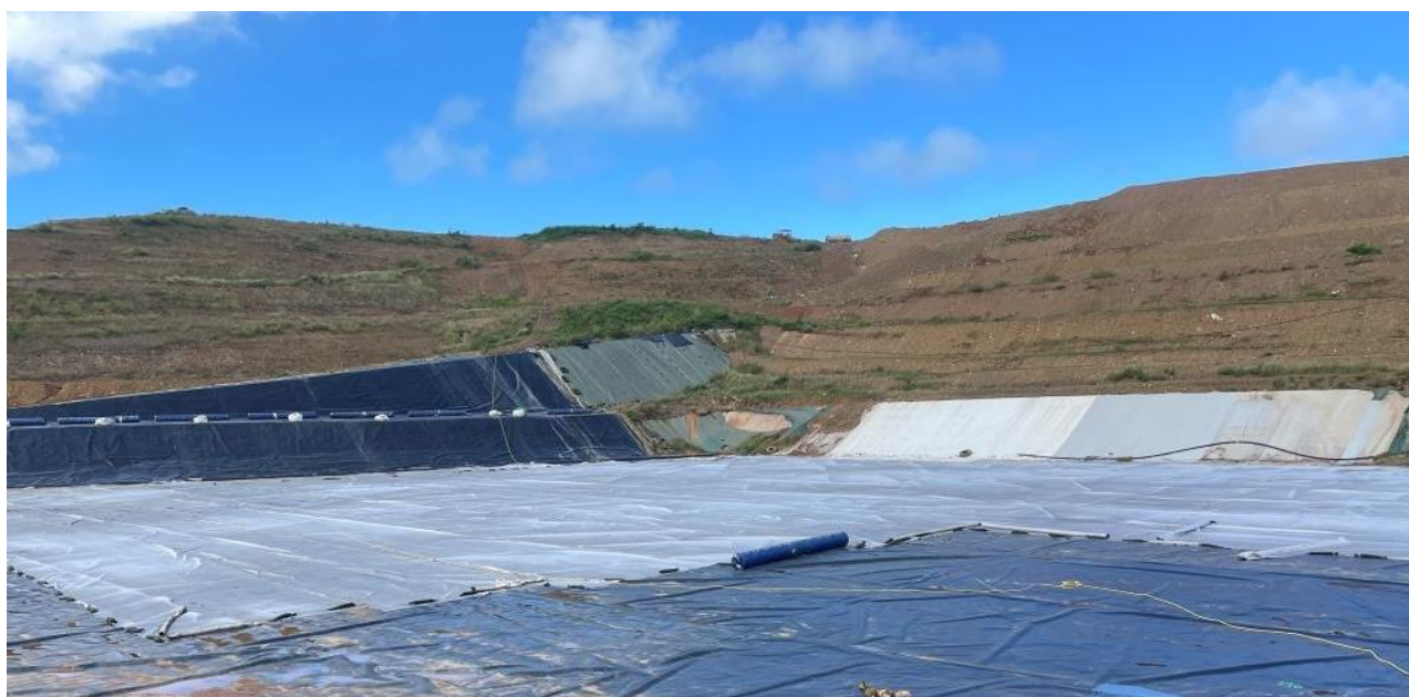
Figure 12 : Pose Géotextile (Bleu) sur géomembrane (noire) au fond de l'alvéole
