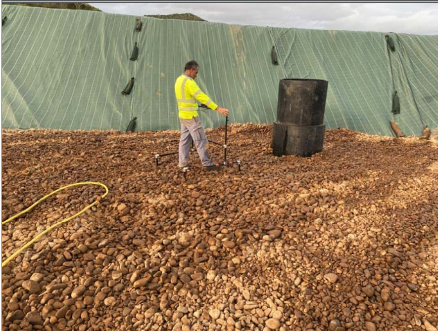
Photo 37: Contrôle au dipôle de la zone après réparation et remblais.
