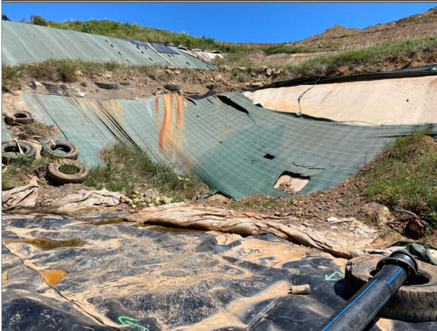
Photo 28: Angle Sud-Ouest du casier E2 à la jonction avec l'ancien casier. La prospection est rendue impossible par la présence de sol. La prospection au dipôle sera favorisée ici.
