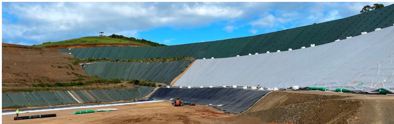
Figure 10 : Talus de haut en bas : Anti-UV (vert), Géotextile(bleu), Geomembrane (noir)
