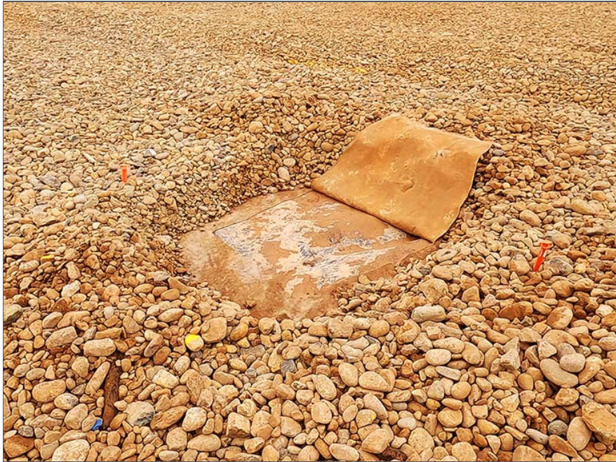
Photo 33 : Suspicion de fuite entre les deux piquets orange. L'opérateur doit alors retirer le recouvrement pour découvrir la géomembrane. L'inspection peut avoir lieu.
