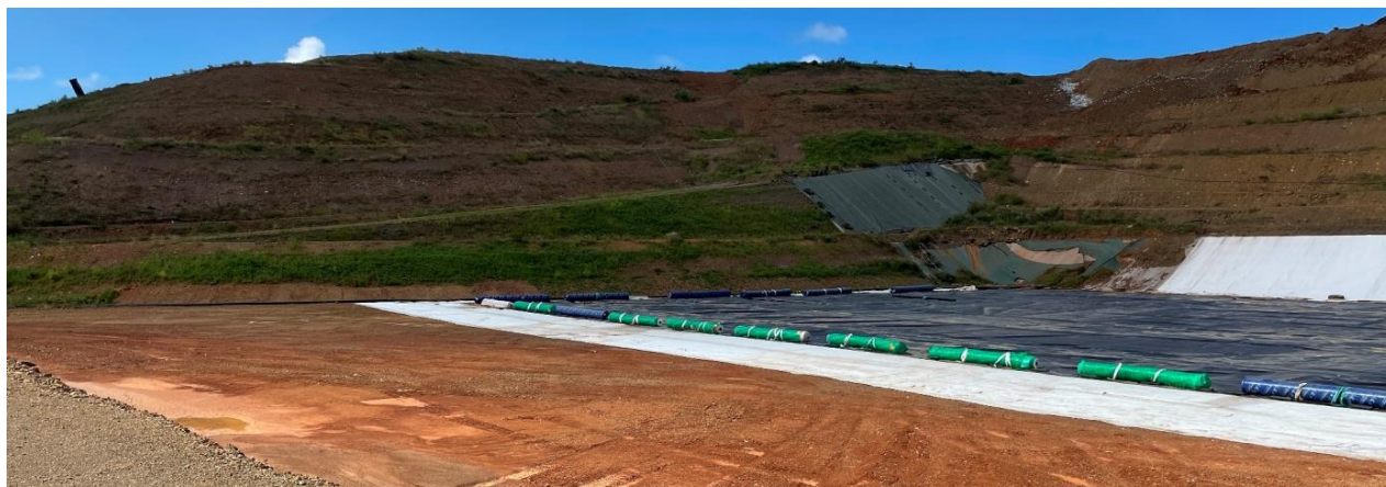
Figure 11 : Pose géomembrane (noire) sur GSB (bleu) au fond de l'Alvéole
