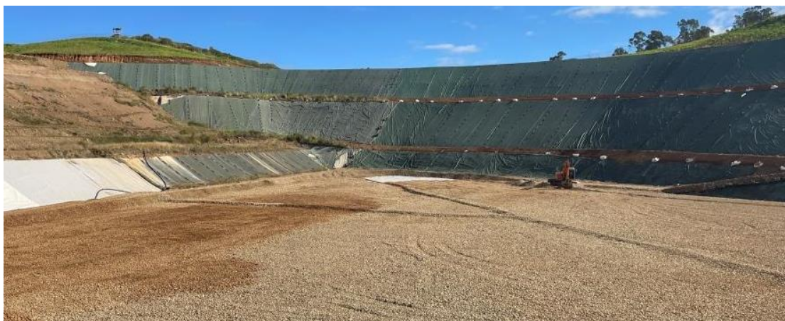
Figure 29 : Photos du massif drainant en 20/80 avant draingom
