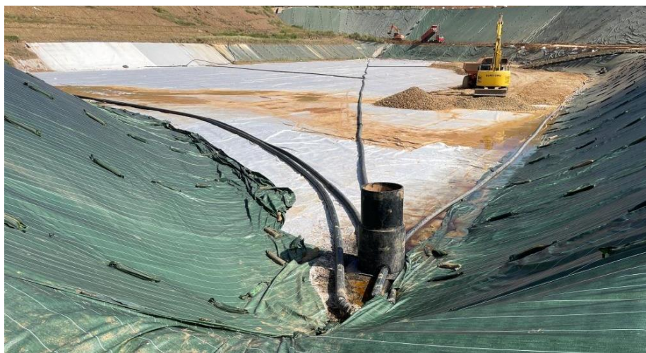
Figure 24 : Photos des réseaux lixiviats dans E2
