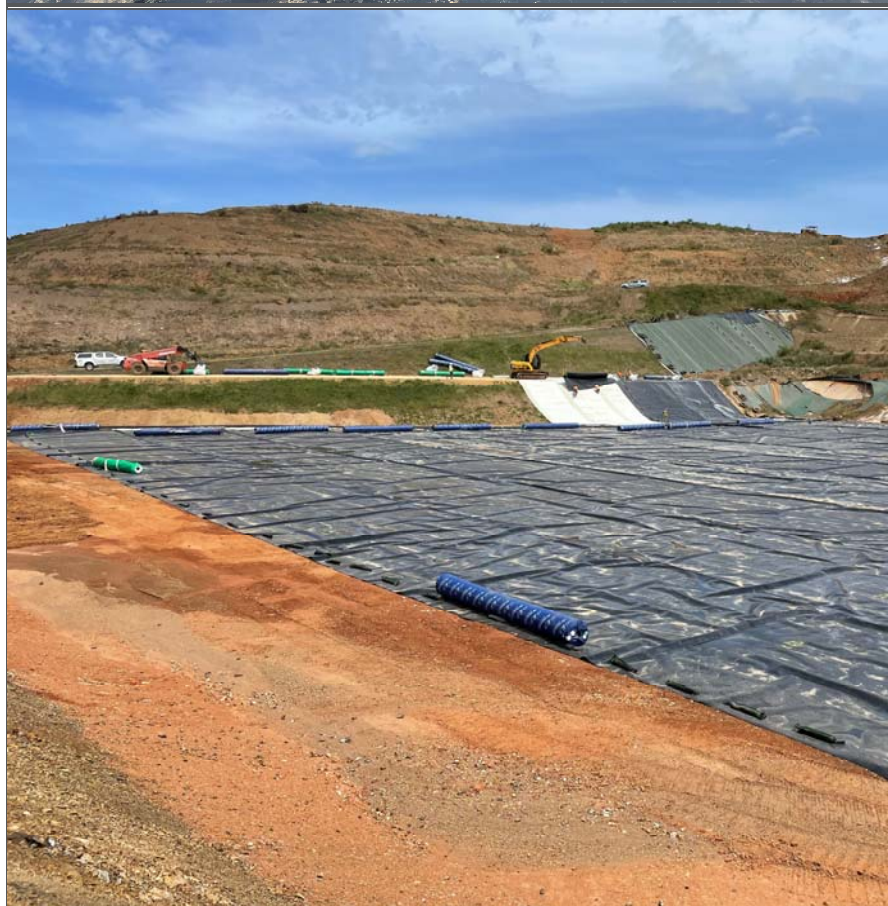
Photo 24: Casier E2 en cours d'étanchéification (la zone posée peut être prospectée à condition l'eau soit contenue sur la surface de la membrane.
