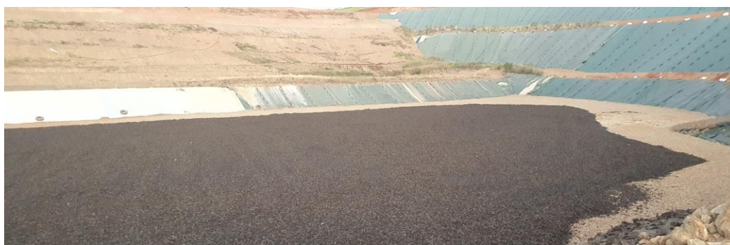
Figure 30 : Mise en place des broyats pneumatiques
