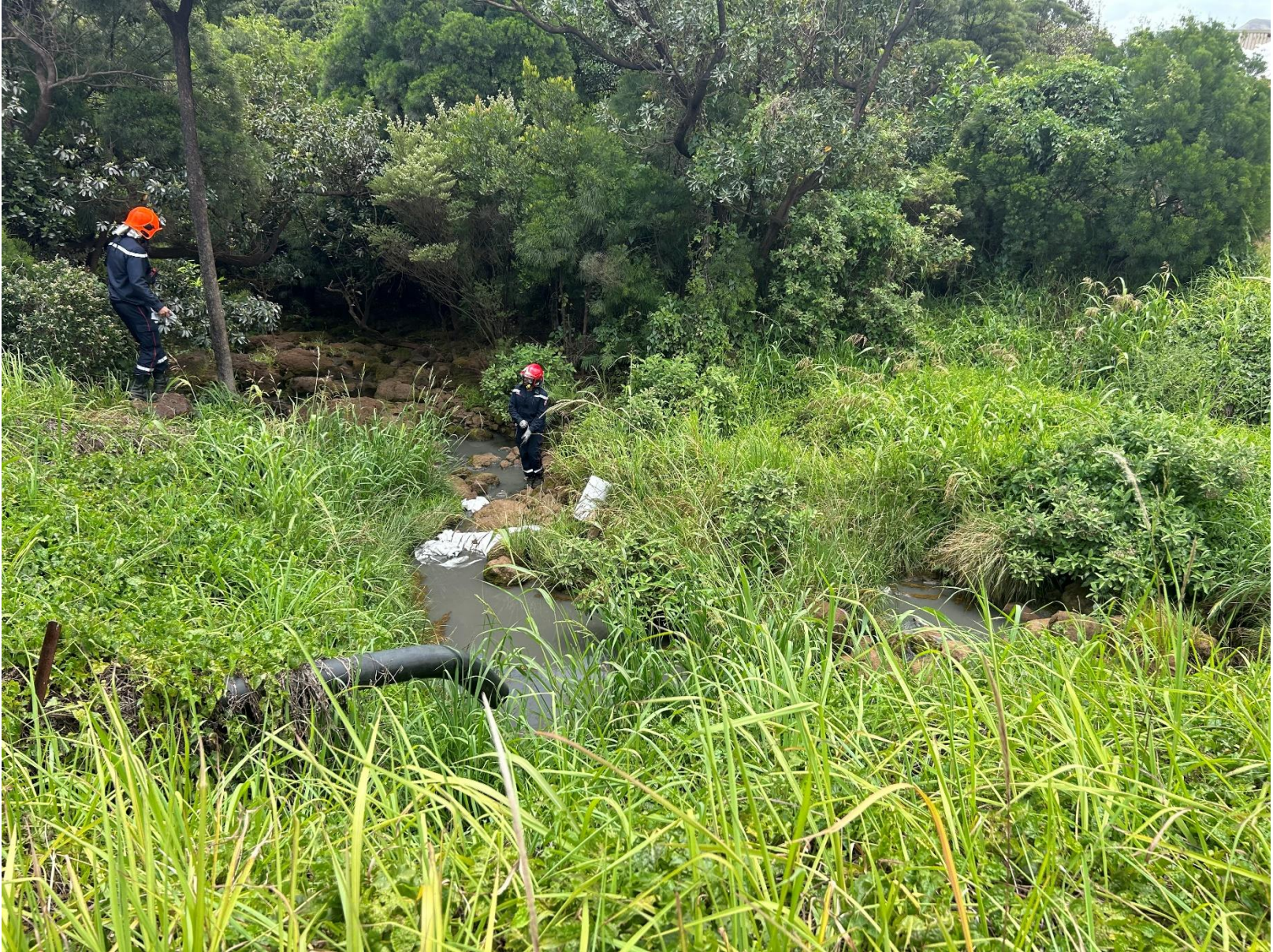
Photo 10– Intervention de la BIPRNC : pose de boudins absorbants pour retenir les sédiments
