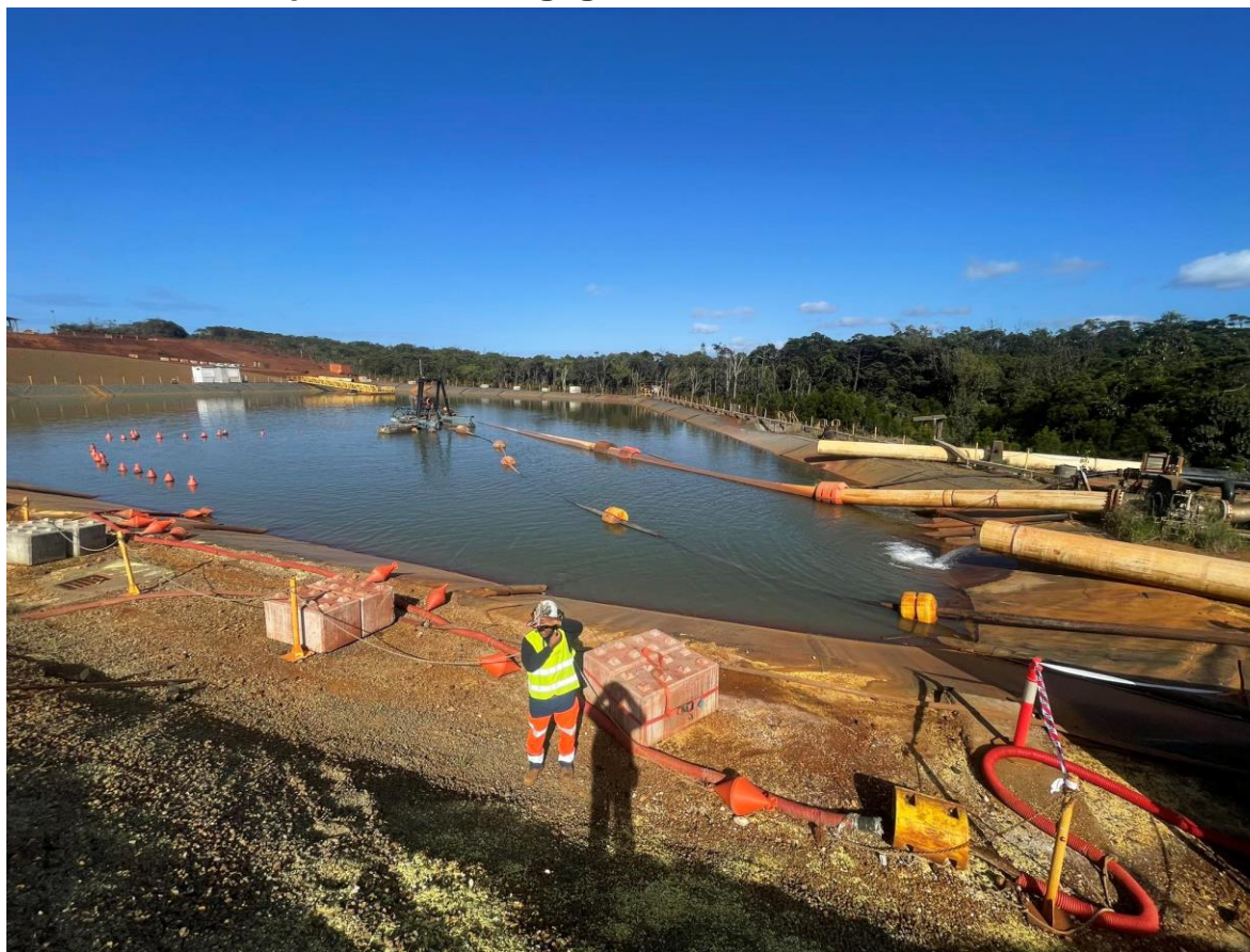
Photo 1 : Opération de dragage des sédiments du bassin de soufre
