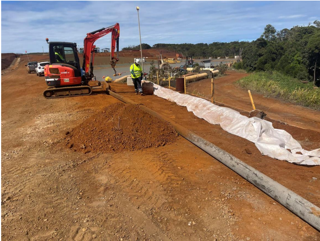
Photos 17 – Mise en place d'un merlon de protection en terre et géotextile afin de confiner les écoulements en cas de fuite/déversement
