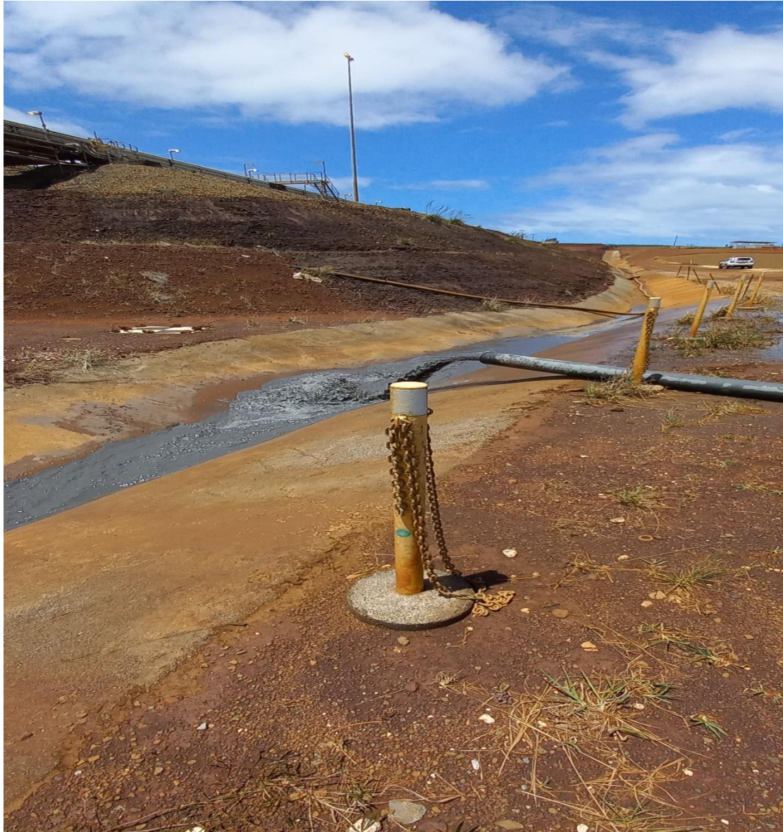
Photo 7 – Canalisations redirigée par le chauffeur de pelle vers le drain connecté au puisard 34/1
