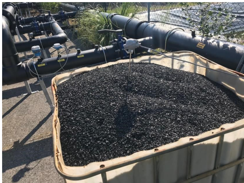
Figure 12 : Stockage temporaire du charbon actif usagé avant évacuation
