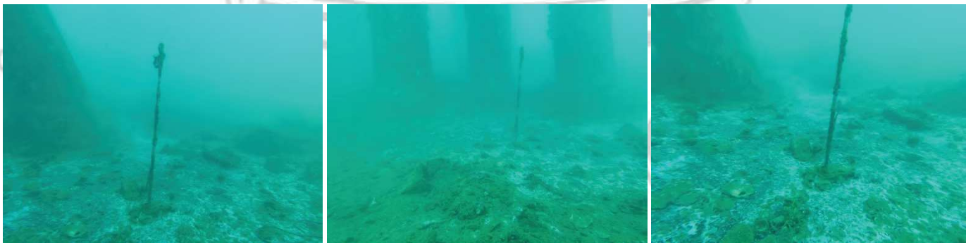
Pieu n°A-8 : Début de reconstitution du merlon de remblai sur zone de déchargement (soufre, charbon, calcaire)
