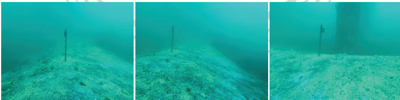
Pieu n°A-8 : Début de reconstitution du merlon de remblai sur zone de déchargement (soufre, charbon, calcaire)
