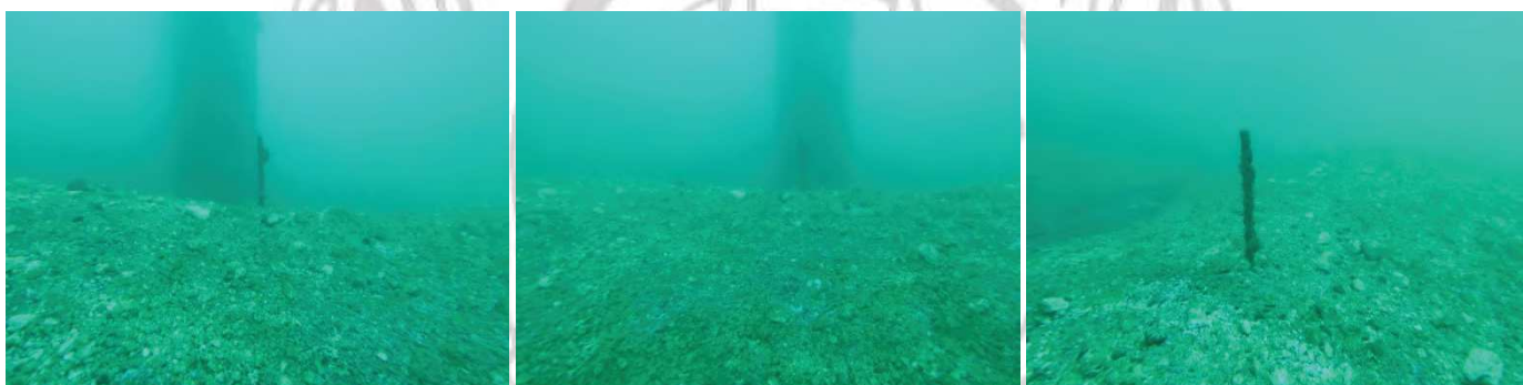
Pieu n°A-12 : Merlon de remblai bien constitué (soufre, charbon, calcaire)
