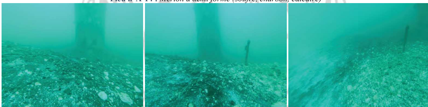
Pieu n°A-14 : Merlon à demi formé (soufre, charbon, calcaire)
