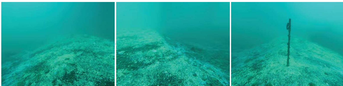
Pieu n°A-9 : Merlon constitué à +1000mm – Base merlon encore étroite
