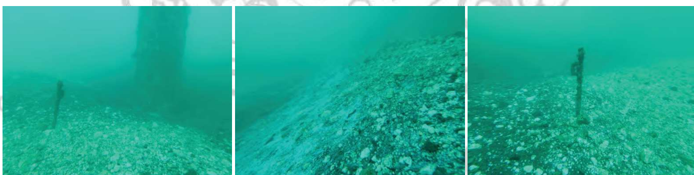
Pieu n°A-15 : Merlon ayant dépassé la hauteur du piquet de référence 1000mm
