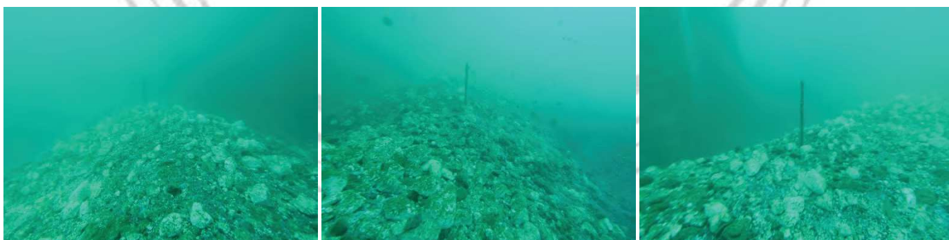
Pieu n°A-15 : Merlon ayant dépassé la hauteur du piquet de référence 1000mm
