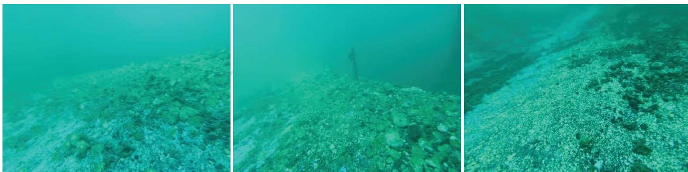
Pieu n°A-12 : Merlon de remblai bien constitué (soufre, charbon, calcaire)
