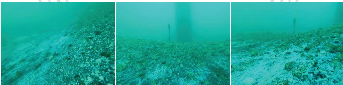
Pieu n°A-13 : Merlon à demi formé (soufre, charbon, calcaire)
