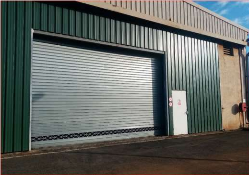
Photo entrée du local de stockage huiles neuves.
