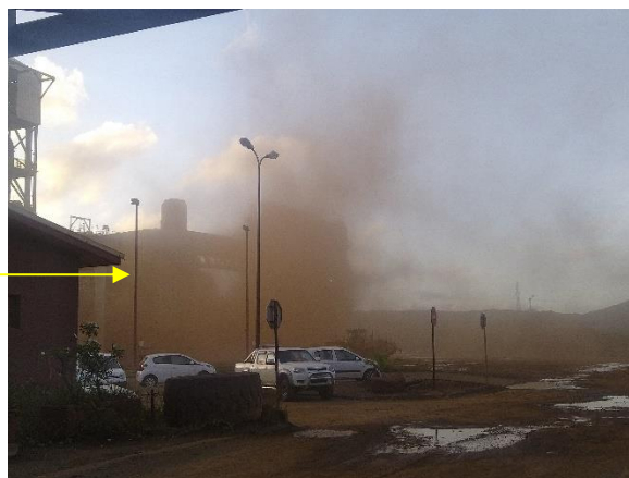
Photo 5 : Emission ponctuelle de poussières diffuses aux sécheurs.
