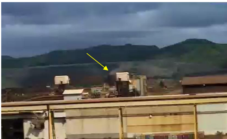
Photo 3 : Image caméra du site à 09h30 le 9/01/2023. Emission ponctuelle de poussières canalisées aux sécheurs.
