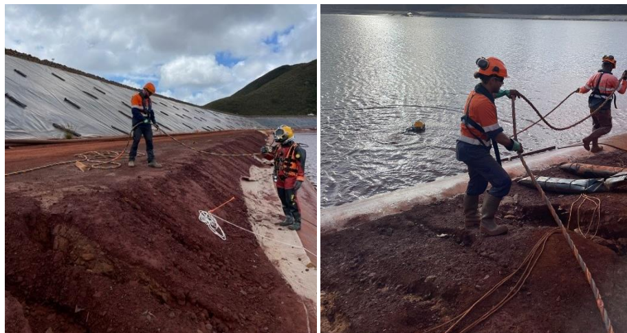
Figure 56. Inspection sous-marine de l'ensemble de la face amont du barrage par un scaphandrier depuis la banquette RL220m (source PRNC)
