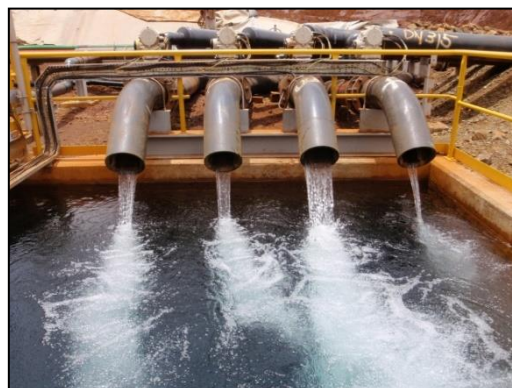
Figure 19. Arrivée des 4 drains sous la géomembrane au puits de pompage aval
