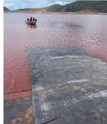
Figure 59. Mise en place du complexe géomembrane + GSB (source PRNC)
