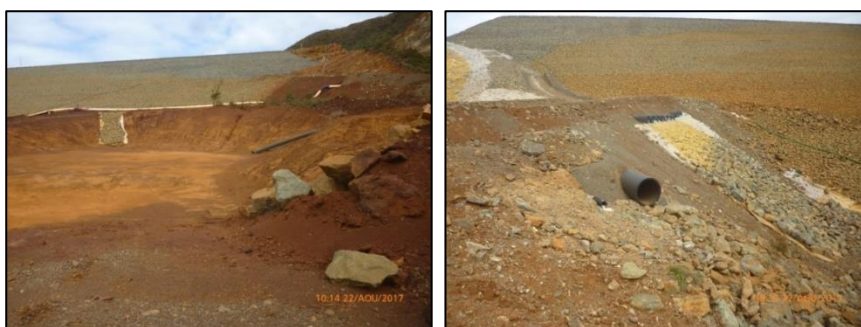
Figure 47. Photos des exutoires des drains horizontaux Nord et Sud
