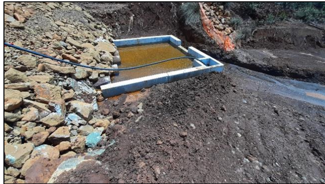
Figure 22. Puisard de reprise des drains de pied
