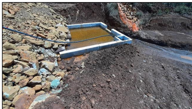
Figure 4-8 : Puisard de reprise des drains de pied
