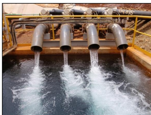
Figure 4-5 : Arrivée des 4 drains sous la géomembrane au puits de pompage aval
