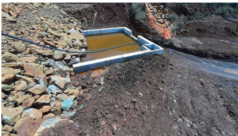
Figure 4-8 : Puisard de reprise des drains de pied
