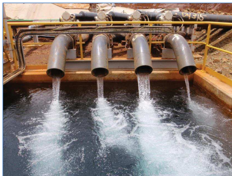
Figure 4-5 : Arrivée des drains sous la géomembrane au puits de pompage aval
