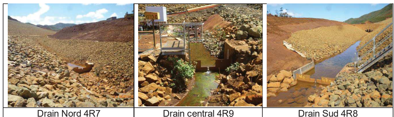
Figure 4-7 : Déversoirs des drains du tapis drainant de la berme
