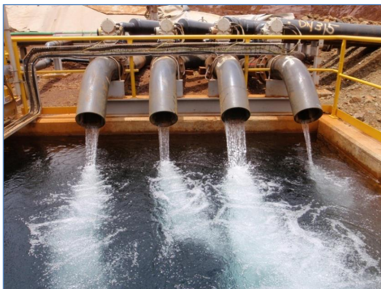
Figure 0-5 : Arrivée des drains sous la géomembrane au puits de pompage aval
