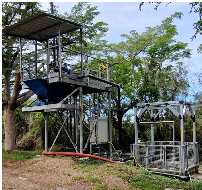
Photo de l'installation temporaire
