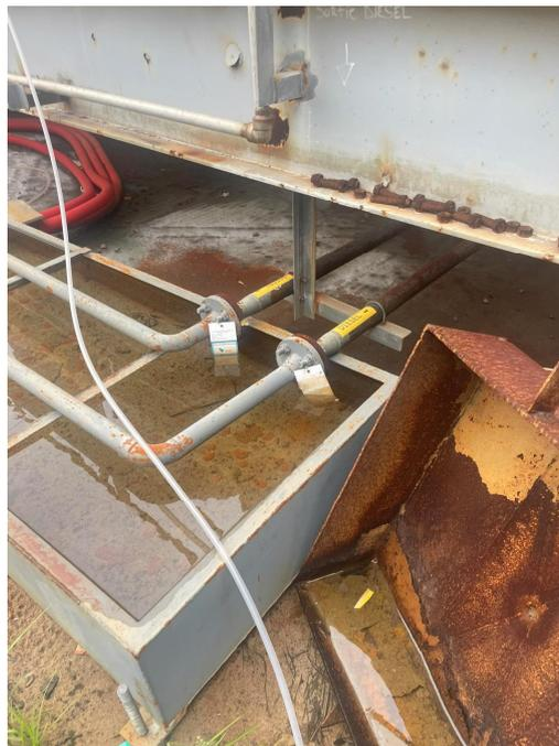
**Figure 11 : Photo point de connexion du gasoil**
