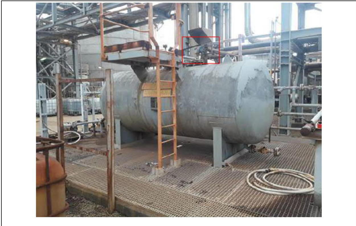
**Figure 9 : Cuve d'alimentation en gazole n° 8303**
