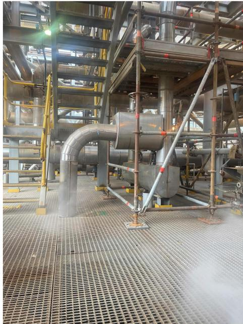
**Figure 12 : Photo point de connexion de l'eau alimentaire MP**
