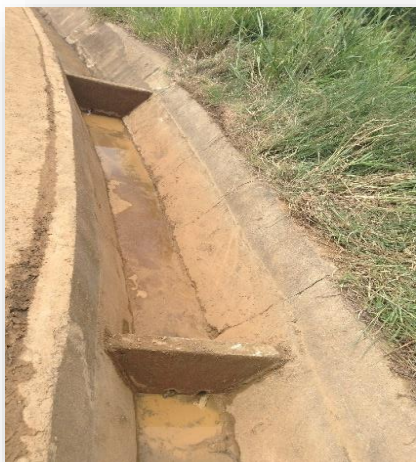
Figure 7 : caniveaux bétonnés avec séparations verticales
