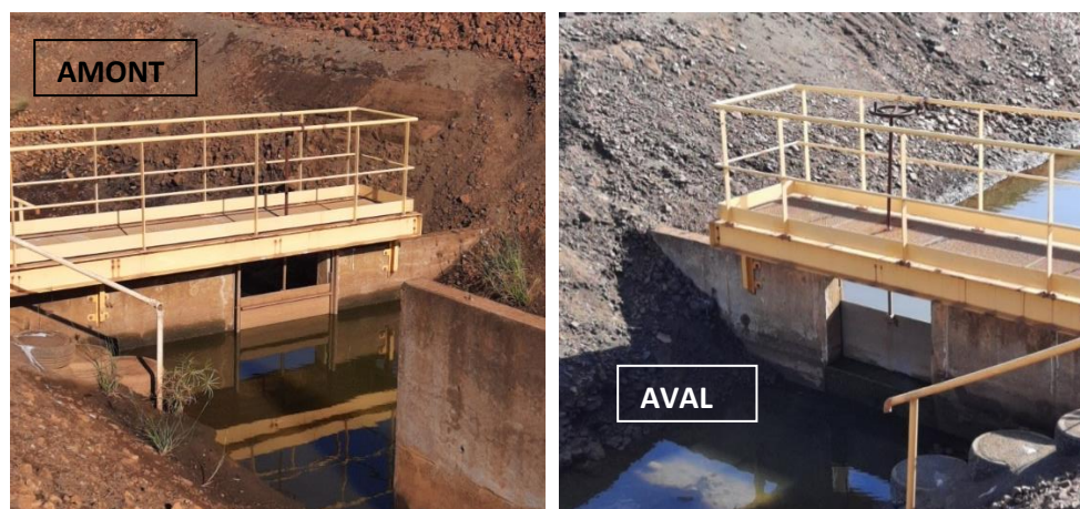
Figure 6: Photographie de la vanne guillotine du point de rejet E4, point où est mesuré le niveau permettant de calculer le débit.
