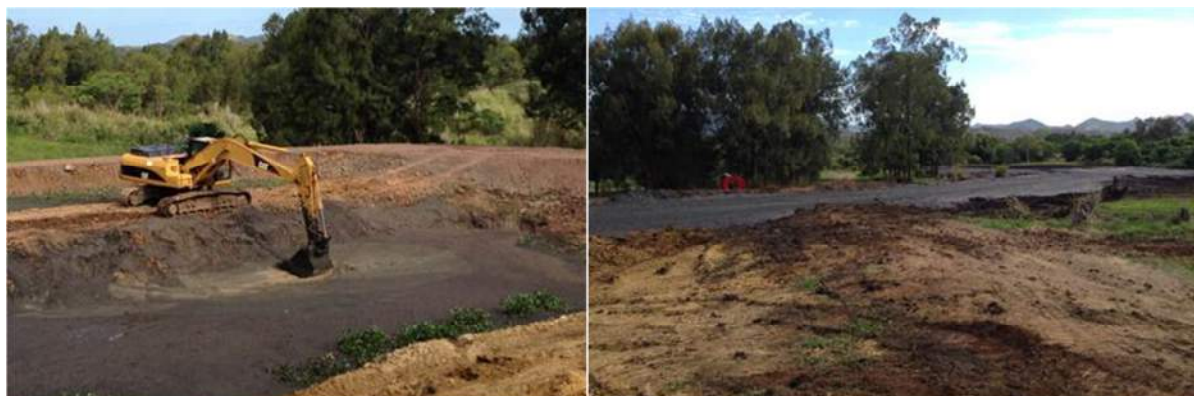
Figure 3 Curage et épandage des boues lagunaires sur le domaine de l'OCEF de Bourail
