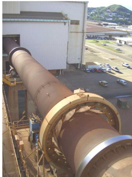
Figure 3 : Photo du FR11 (vue depuis l'amont vers le FD)
