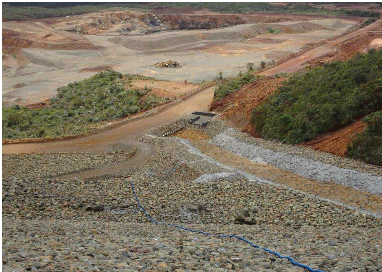
Figure 67: Vue sur l'aval du coursier enroché récupérant les eaux du drain de dérivation sud et du bassin versant du dog-leg [53]
