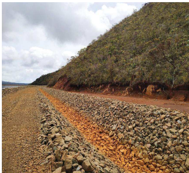
Figure 65: Vue sur le drain de dérivation sud des eaux de ruissellement (GEOs4D, le 24/11/2021)
