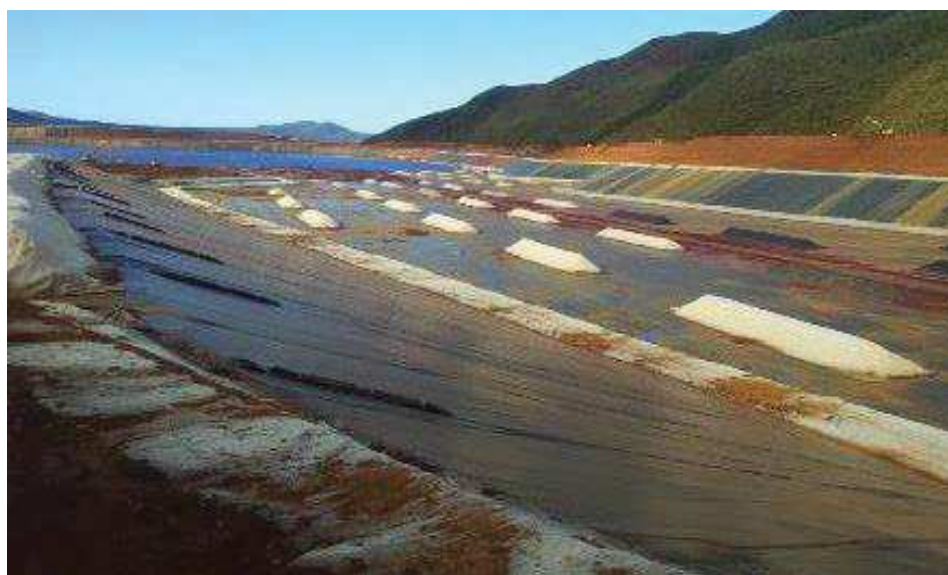
Figure 59: Vue sur la géomembrane et lests en fond de bassin lors de la phase de construction de l'aire de stockage KO2 (Source [10])
