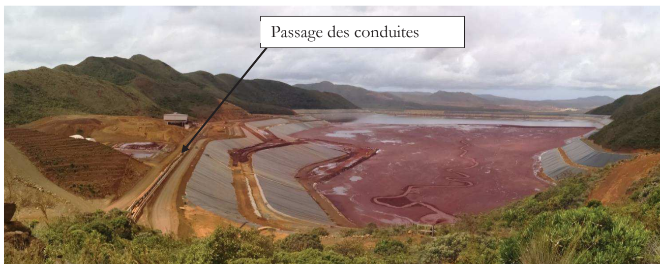
Figure 17 : Vue d'ensemble sur l'amont du Parc à résidus KO2 avec le passage des canalisations de transfert des résidus en pulpe visible en rive gauche (photo aérienne de 2019)
