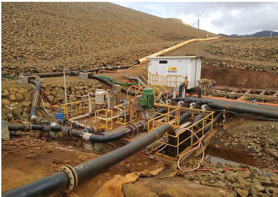
Figure 61: Vue sur le puits de pompage à l'aval du barrage (Source : GEOs4D, le 18/11/2021)
