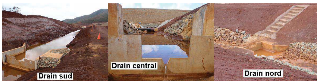
Figure 62: Vue sur les drains (fossés) de pied aval du barrage [10]
