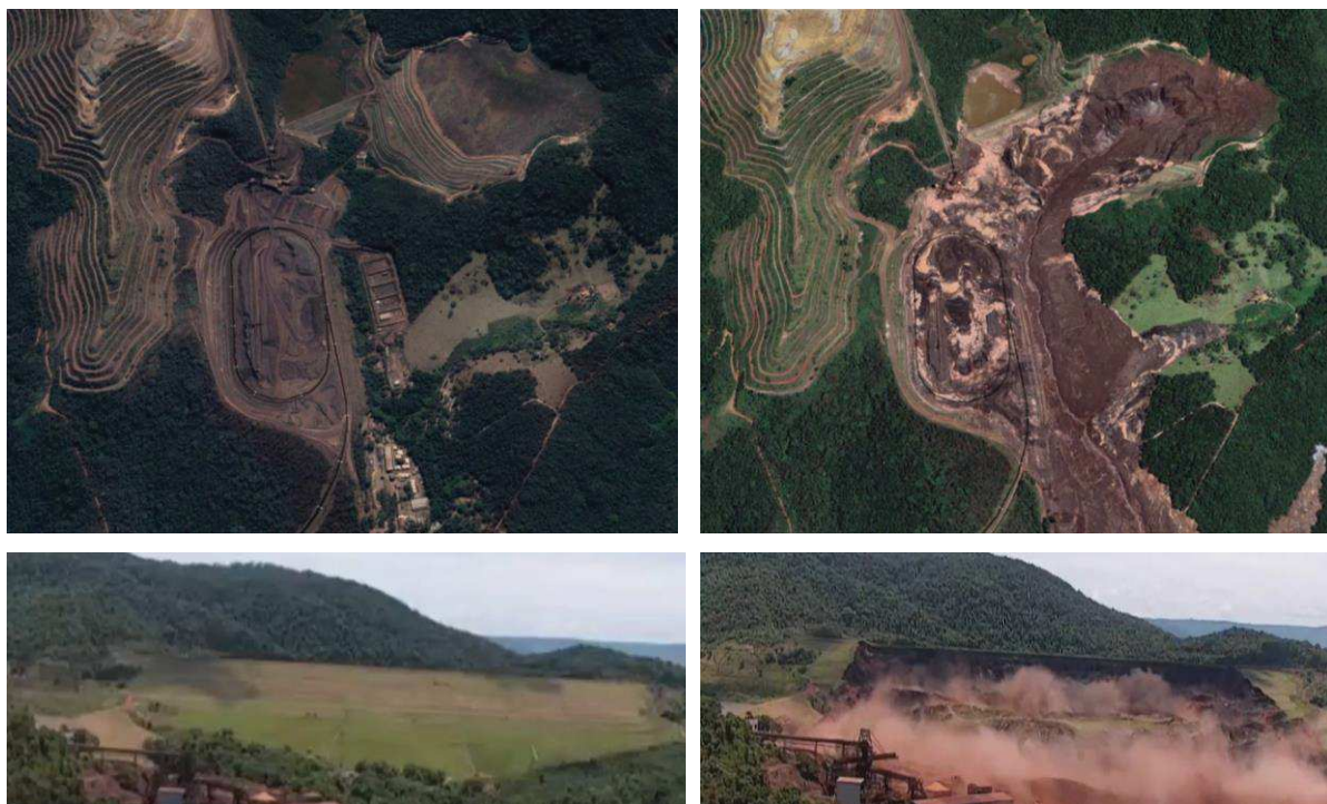
Figure 111 : Vues avant/après de la rupture du parc à résidus
