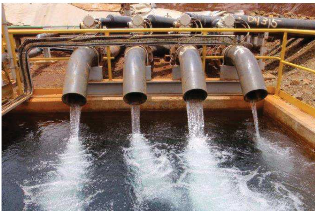
Figure 15 : Vue sur les 4 exutoires des conduites des 4 secteurs du système de drainage sous la géomembrane [Réf.1]
