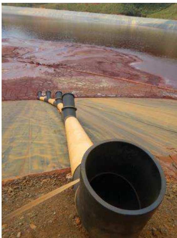
Figure 68: Vue sur une station de décharge (exemple station 2-1 du talus 206/220, aujourd'hui bétonnée), [44]
