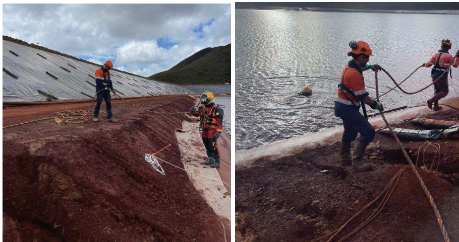
Figure 80 : Inspection sous-marine de l'ensemble de la face amont du barrage par un scaphandrier depuis la banquette RL220m (source PRNC)
