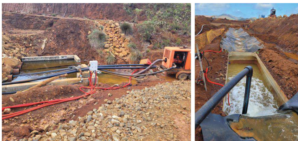
Figure 63: Puisard de collecte et container enterré (décembre 2022)
