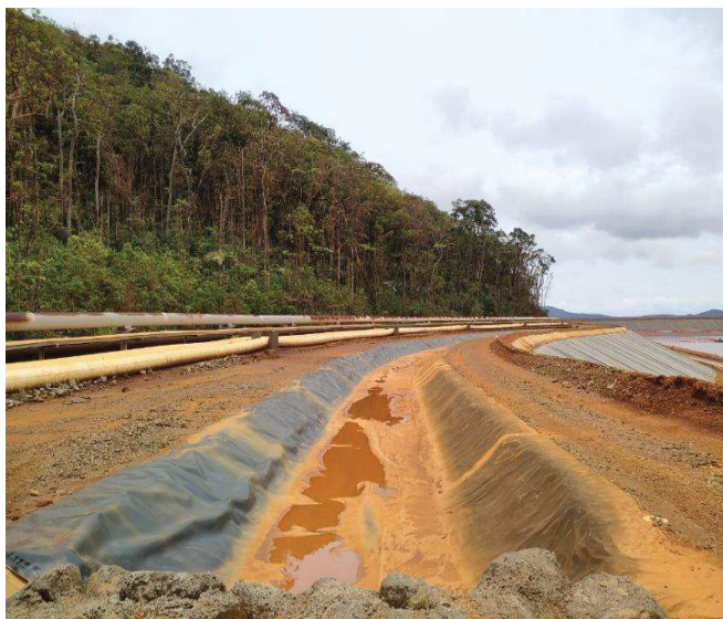
Figure 64: Vue sur le drain de dérivation nord des eaux de ruissellement (GEOs4D, le 24/11/2021)
