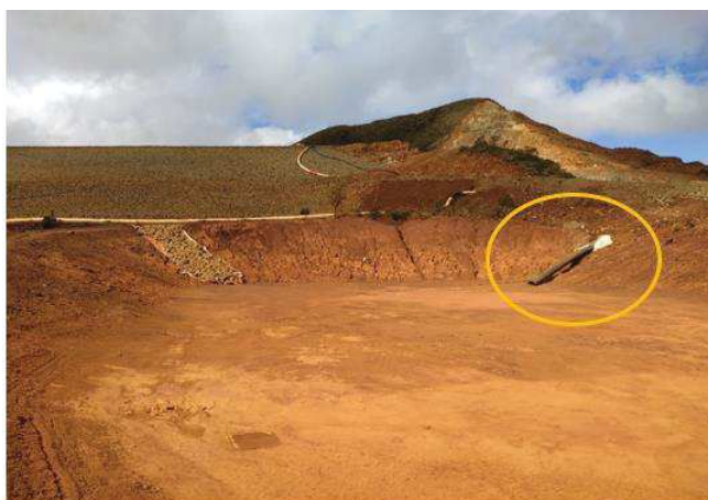
Figure 69: Vue sur l'exutoire du drain horizontal de subsurface Nord se rejetant dans le bassin de sédimentation KW-D33 (GEOs4D, le 18/11/2021)
