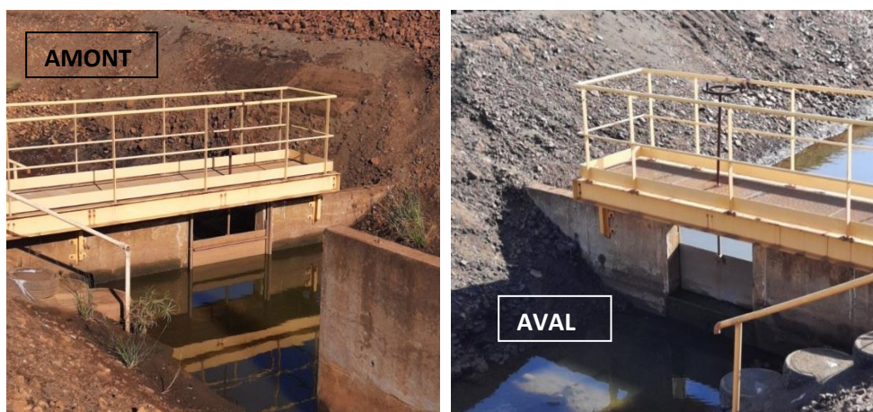
Figure 7: Photographie de la vanne guillotine du point de rejet E4, point où est mesuré le niveau permettant de calculer le débit.
