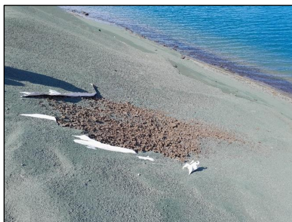
Figure 4: Sortie du drain au niveau de la zone maritime (Audit S2-2024)
