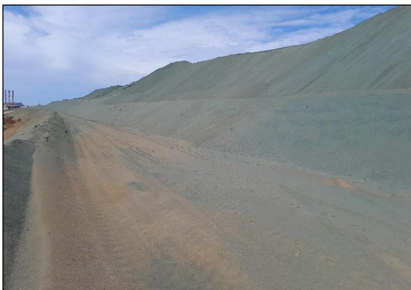
Figure 2 : Reprofilage du talus Est de la verse (Audit S2-2024)
