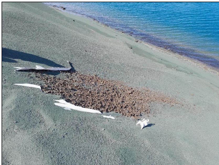
Figure 3 : Sortie du drain au niveau de la zone maritime (Audit S2-2024)
