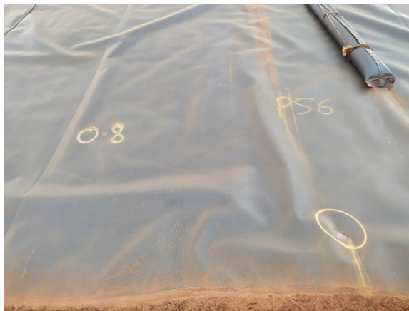
Photo 28 : Perforations dans la géomembrane
