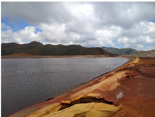
Photo 11 : Erosion du ballast de la banquette
