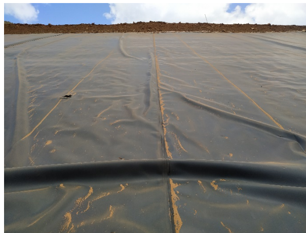
Photo 8 : Plis horizontaux dans la géomembrane
