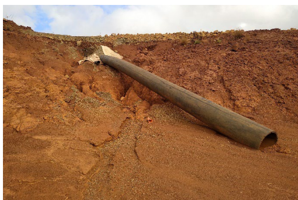
Photo 84 : Exutoire drain horizontal nord
