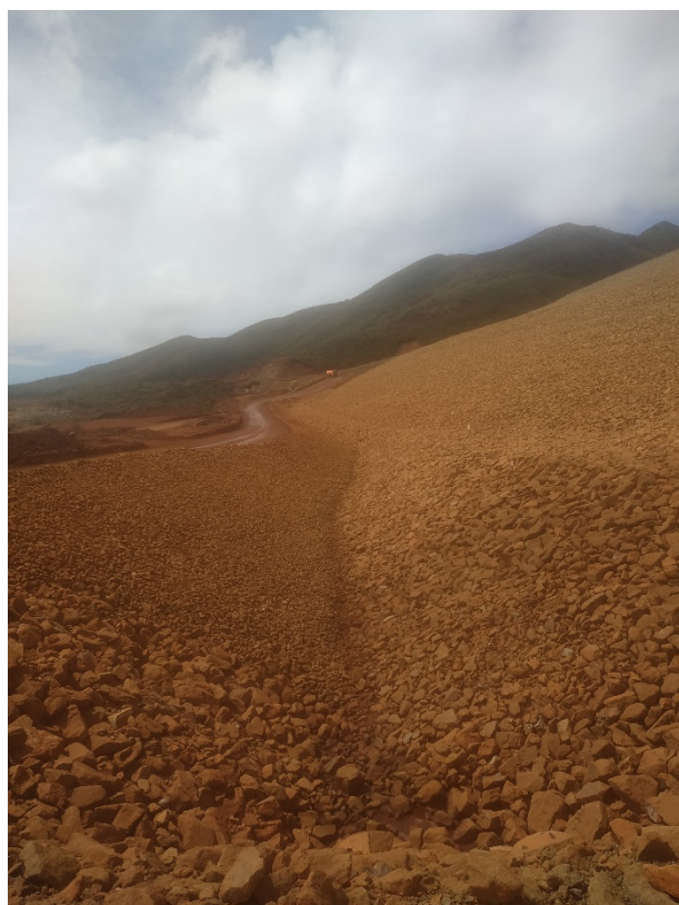
Photo 87 : La mise en œuvre du géotextile et du riprap entre l'amont et l'aval du seuil de mesure n'est pas identique
