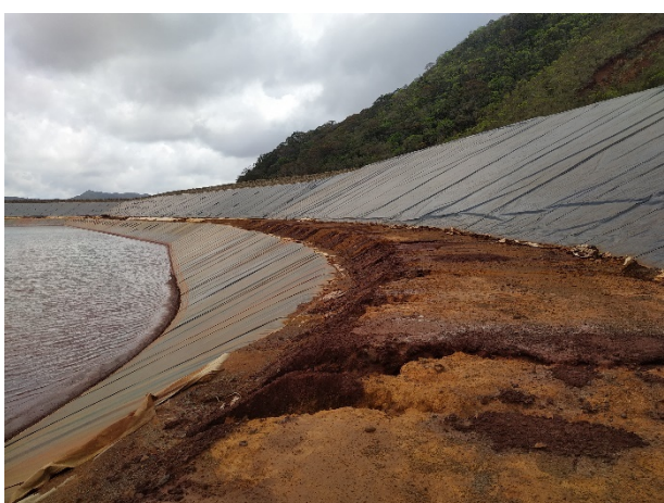
Photo 15 : Absence de géotextile sur la banquette
