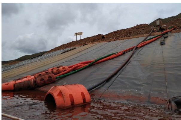
Photo 115 : Gaine de protection ouverte sur le talus
