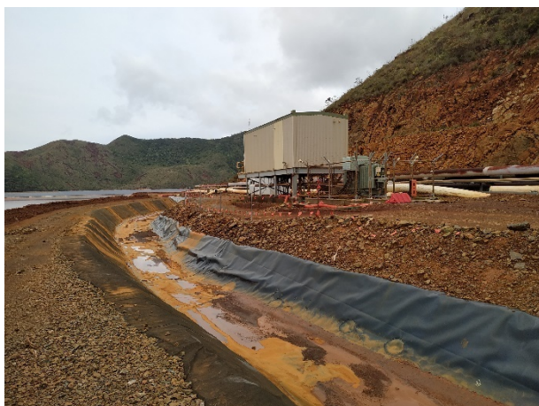
Photo 79 : Chute des blocs et cailloux dans l'exutoire du drain de dérivation nord
