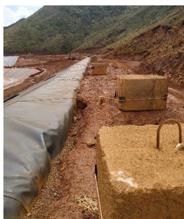
Photo 22 : léger affouillement des matériaux d'ancrage de la géomembrane sur la crête à l'ouest de l'aire de stockage
