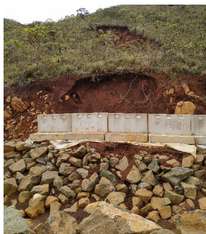
Photo 72 : vue sur un des parements passifs en bloc béton en « L » le long du drain de dérivation sud et éboulement
