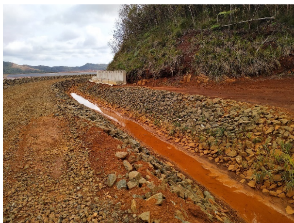
Photo 62 : Eau stagnante et accumulation de matériaux fins
