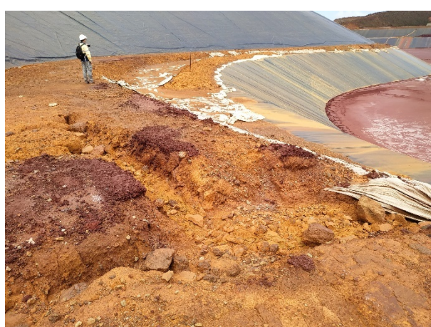
Photo 14 : Erosion du ballast et réparation avec des résidus séchés
