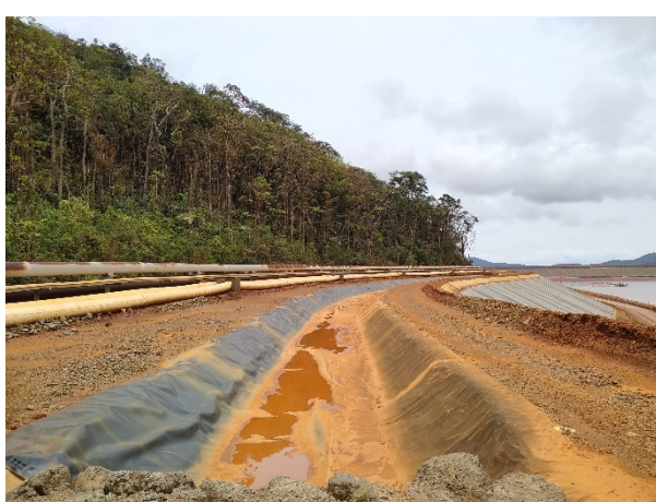
Photo 74 : Eau stagnante, accumulation des matériaux fins
