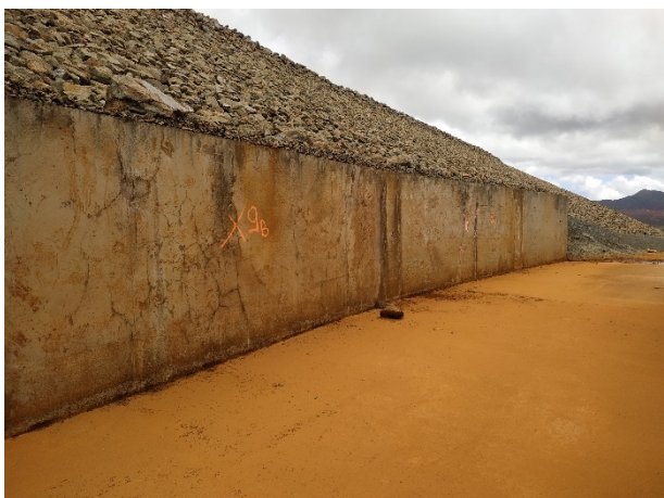
Photo 67 : Blocs dans le bajoyer en provenance du talus
