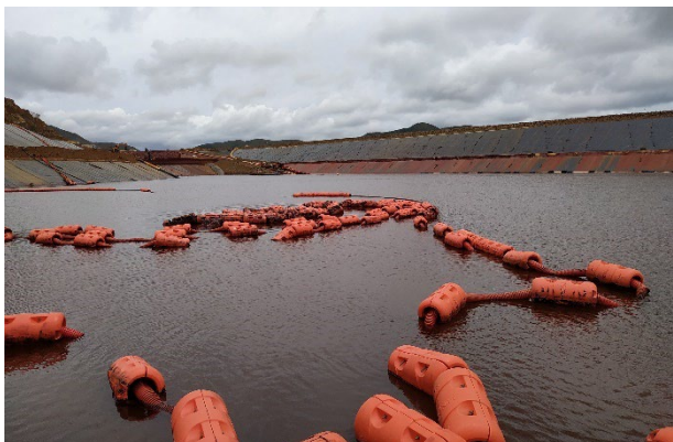
Photo 114 : Gaine de protection ouverte dans la zone inondée
