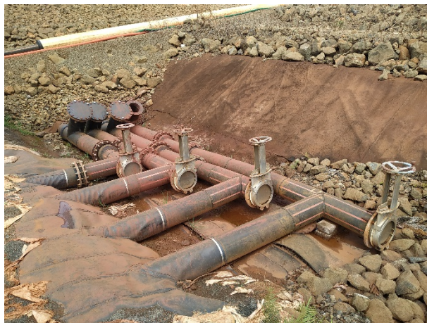
Photo 52 : Conduites du système de drainage de la sous-face de la géomembrane en fond de bassin
