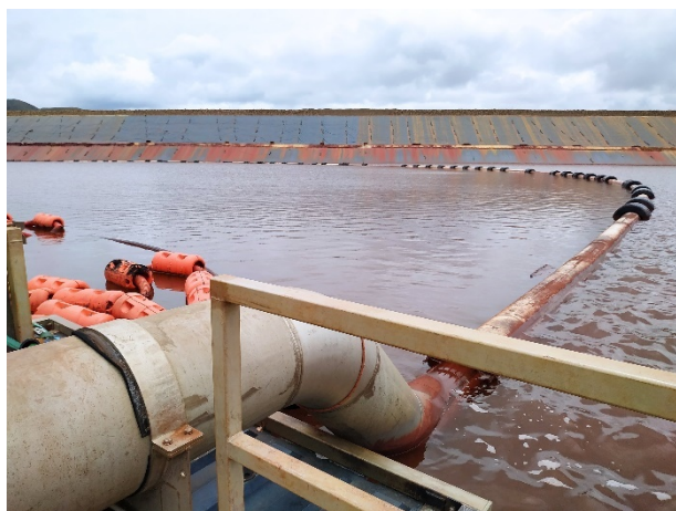
Photo 105: Ligne de pompage de la barge
