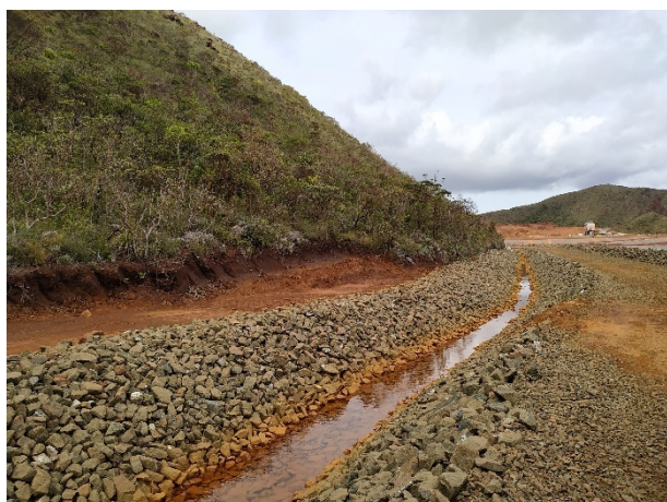
Photo 61 : Eau stagnante dans le drain
