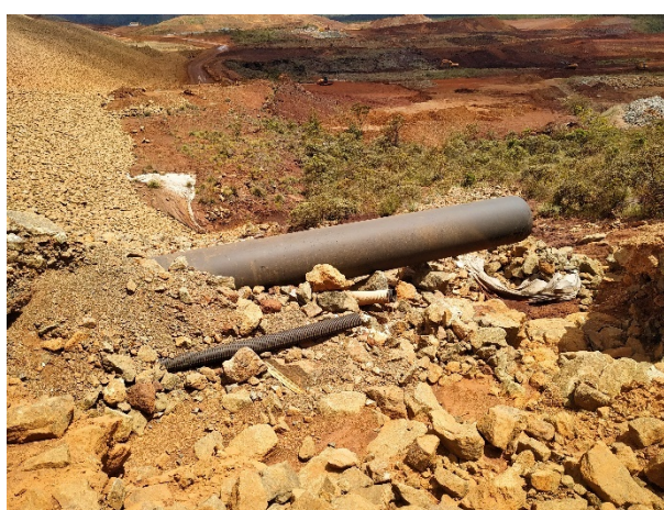
Photo 82 : Detail drain horizontal sud
