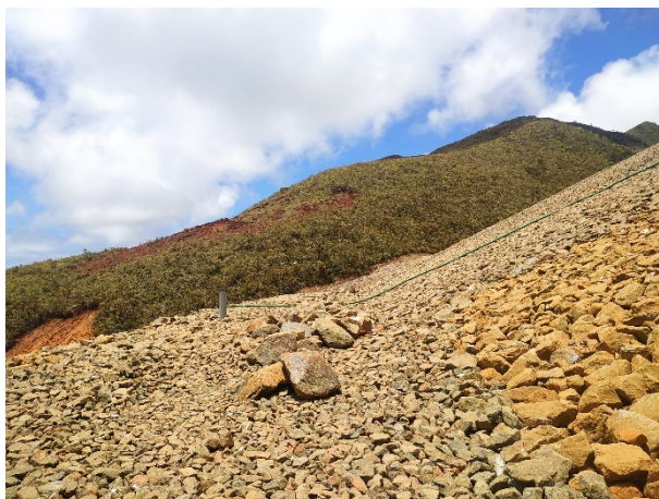
Photo 43 : Blocs tombés suite aux travaux de forage
