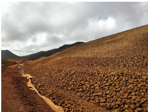
Photo 90 : En amont du busage, le talus n'est pas entièrement protégé par le riprap et le géotextile
