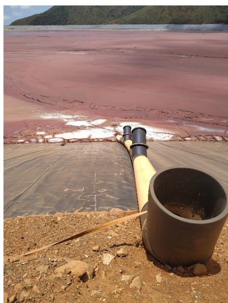
Photo 142 : Station de décharge comblée au béton
