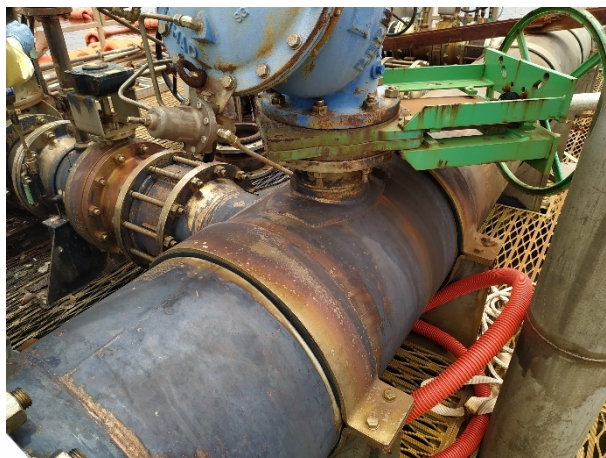
Photo 117 : Légères traces de corrosion
