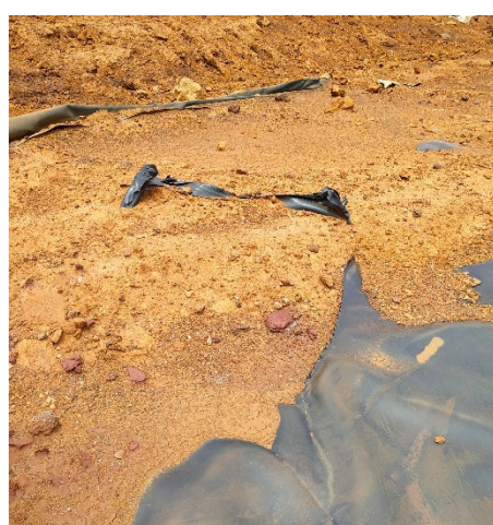
Photo 16 : Un déchirement de géomembrane a été observé au droit de la zone de travaux W05-W07. La déchirure est en partie sous la latérite du ballast et donc difficilement visible.
