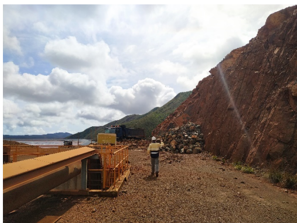
Photo 97 : Chute des blocs au niveau du talus sud au droit de la traversée des tuyaux d'acheminement sous la route
