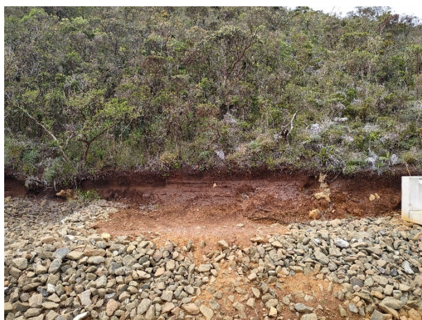
Photo 60 : Accumulation de matériaux fins
