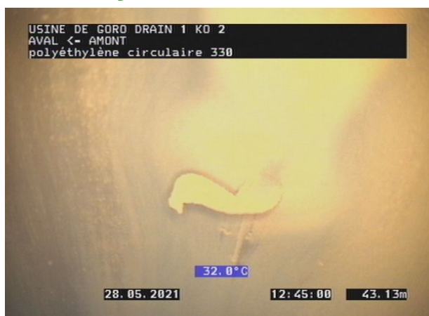
Photo 128 : Drain 1 abrasion
