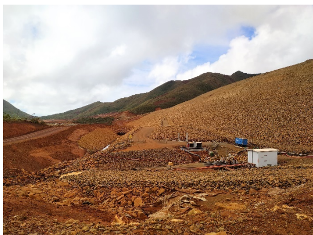
Photo 91 : En aval du busage, le talus en rive gauche est entièrement à nu et le fond de fossé est encombré par des géotextiles et des blocs
