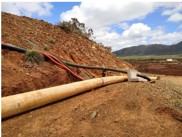
Photo 53 : Conduite de retour depuis le puits de pompage vers l'appui nord
