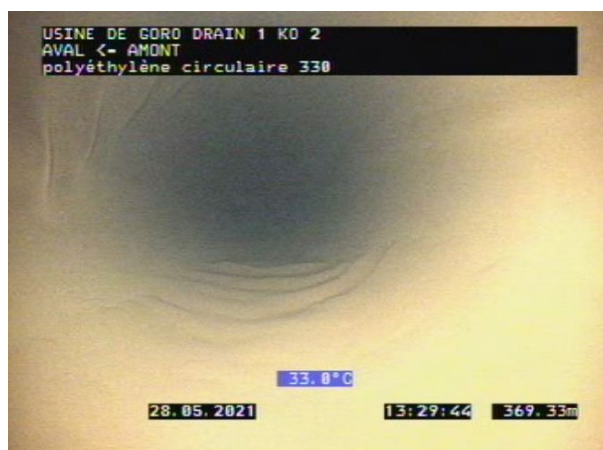
Photo 129 : Drain 1 bourrelet soudure et dépôt
