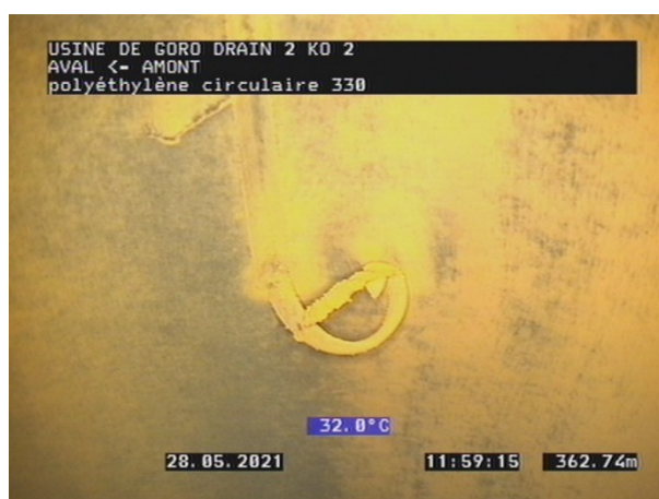
Photo 131 : Drain 2 abrasion
