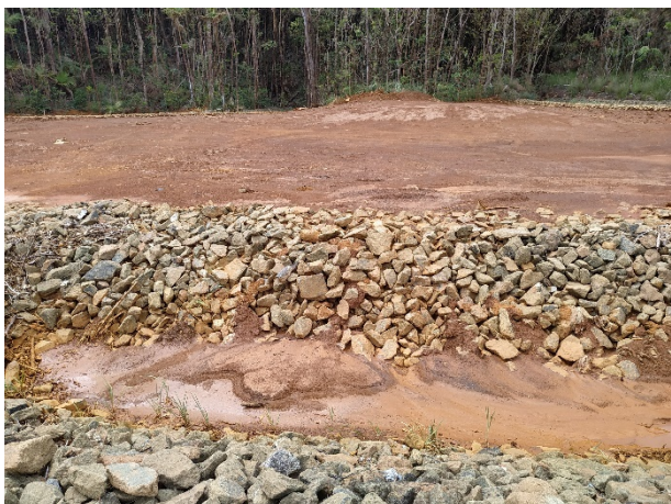
Photo 63 : Accumulation de matériaux fins
