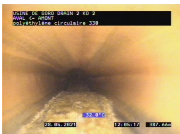
Photo 133 : Drain 2 rupture de pente
