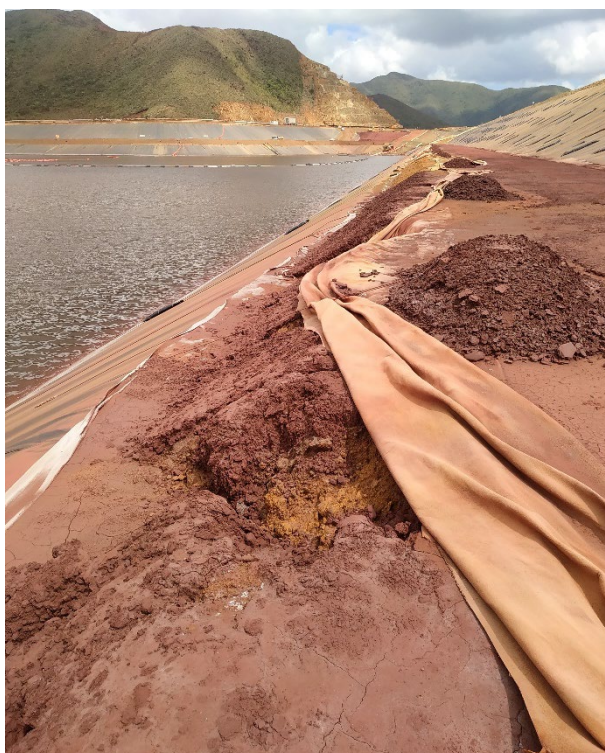
Photo 32 : Géotextile déchiré et ravinement
