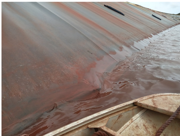
Photo 26 : Bloc poinçonnant la géomembrane
