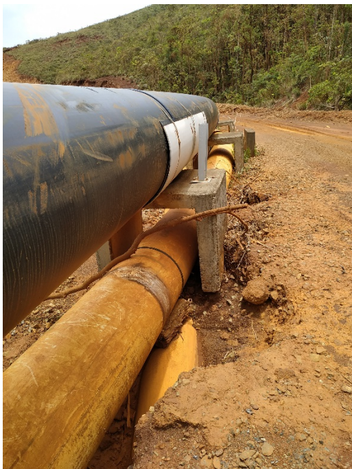
Photo 99 : Affouillement des matériaux de fondation du réseau de pipes
