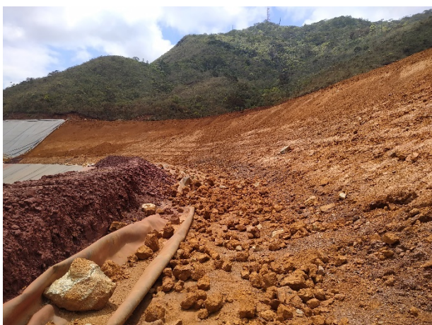
Photo 9 : Partie sud-ouest, sans géomembrane
