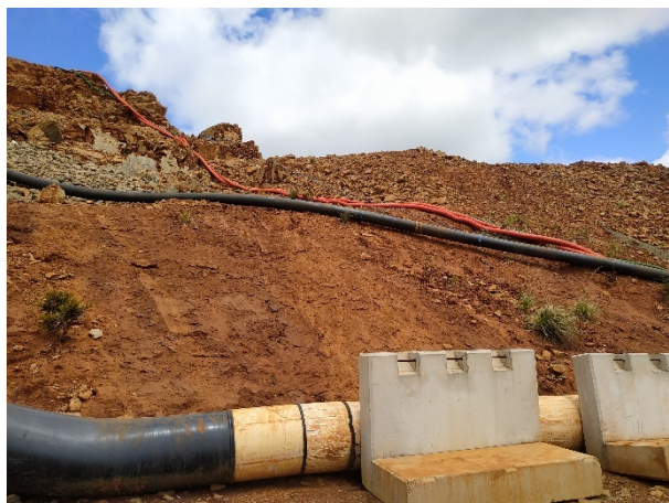
Photo 54 : Ligne 315 mm accrochée à l'aide d'un fin câble
