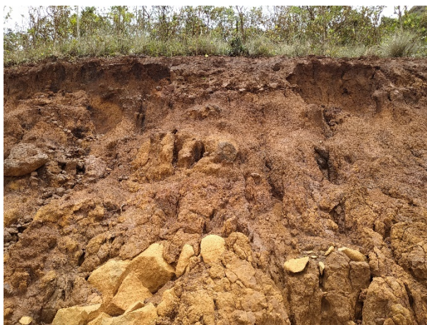
Photo 78 : Erosion talus au droit du drain
