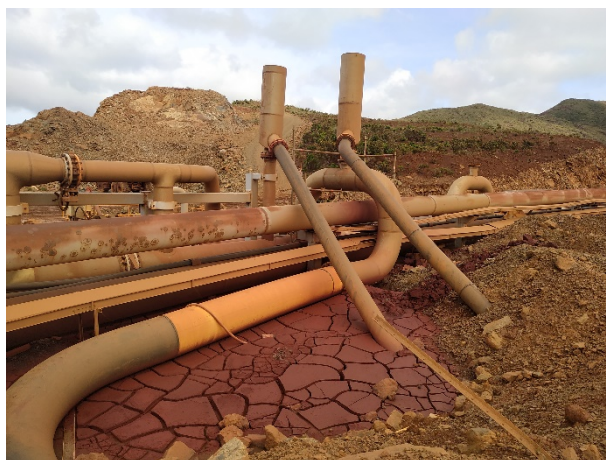
Photo 96 : Traces de corrosion sur les tuyaux de distribution et fuite de résidus
