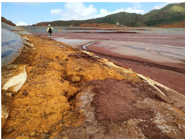
Photo 13 : Erosion du ballast et réparation avec des résidus séchés
