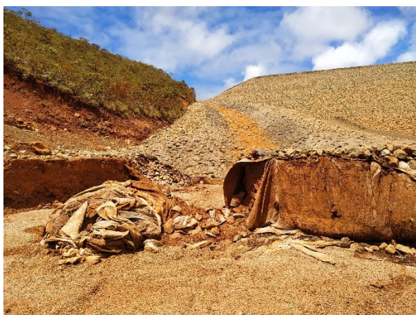
Photo 68 : Géotextile déchiré au droit de l'exutoire du drain de dérivation sud
