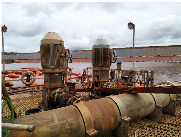
Photo 113 : Pompes et traces de corrosion
