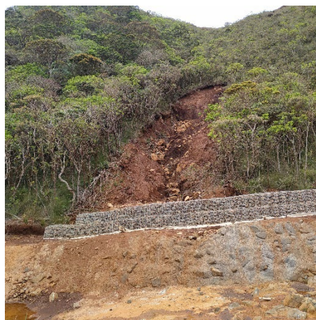
Photo 70 : Vue sur les travaux de soutènement effectués suite aux intempéries de février 2020 (vue de face)
