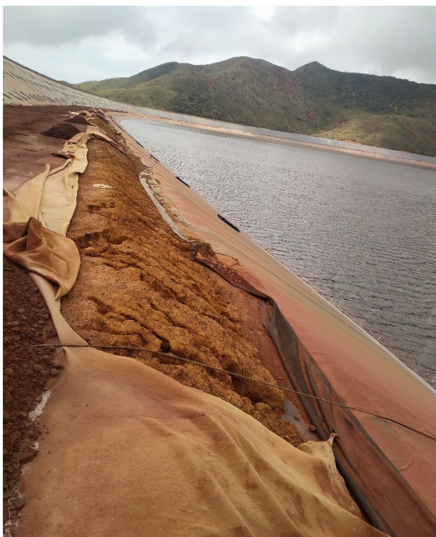
Photo 31 : Géotextile déchiré et ravinement
