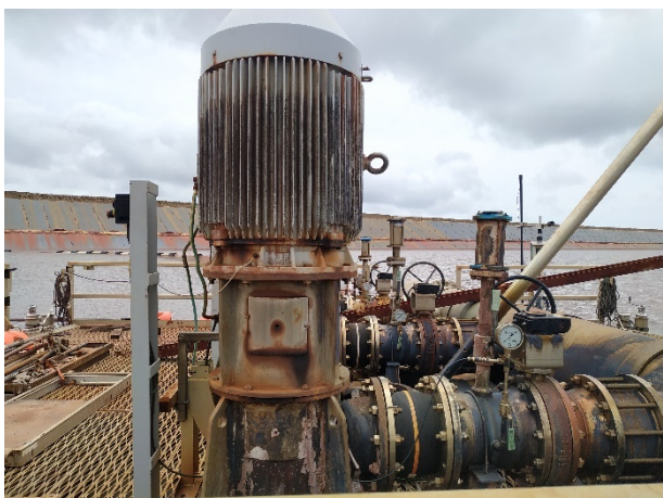
Photo 112 : Pompe et traces de corrosion
