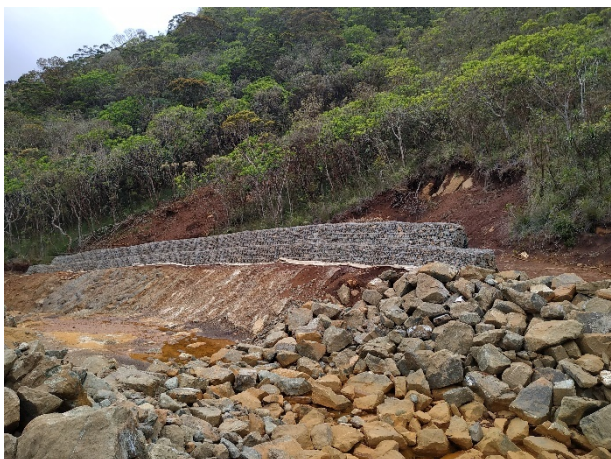
Photo 69 : Vue sur les travaux de soutènement effectués suite aux intempéries de février 2020 (vue sur mur de gabion en début de coursier)
