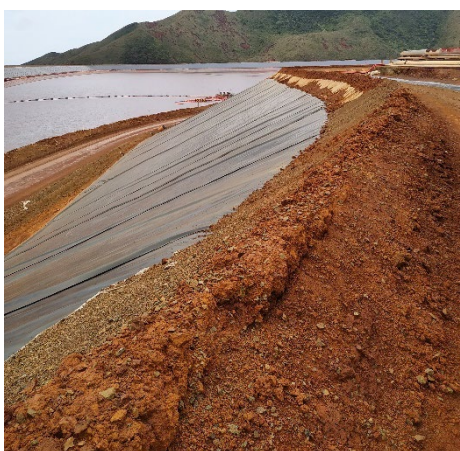
Photo 21 : Le merlon au niveau de la crête au nord de l'aire de stockage est légèrement raviné sur les portions non protégées par un géotextile
