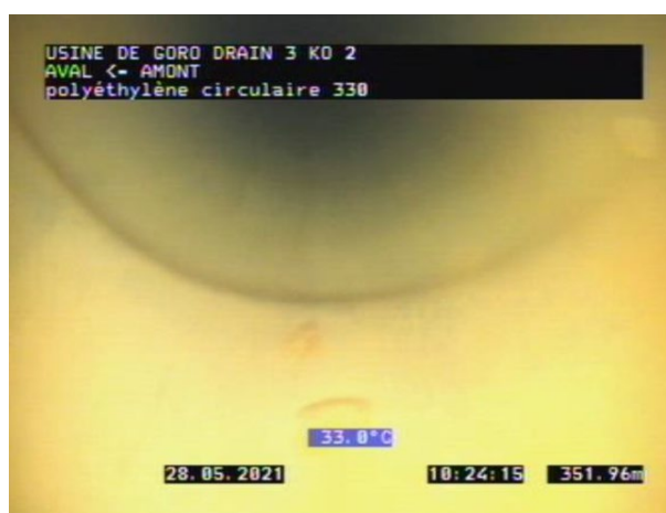
Photo 137 : Drain 3 pliure
