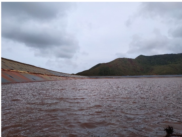
Photo 23 : Parement amont
