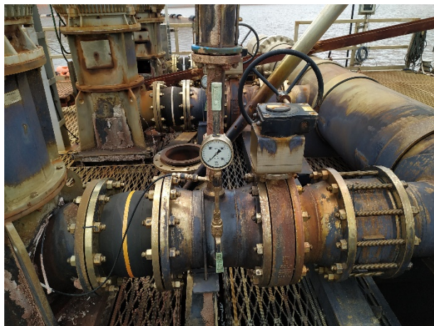
Photo 116 : Légères traces de corrosion
