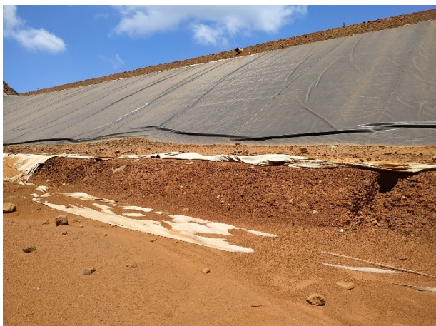
Photo 17 : Banquette est endiguée par 2 cordons de latérite de part et d'autre de la banquette, encapsulés par un géotextile. Le géotextile est ouvert sur plusieurs mètres à plusieurs endroits.
