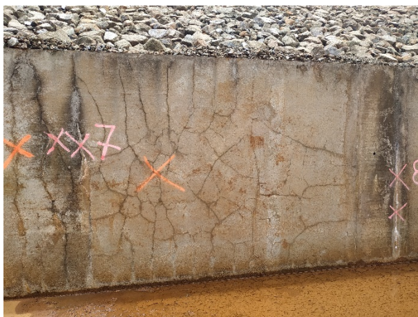
Photo 66 : Fissuration dans le bajoyer béton
