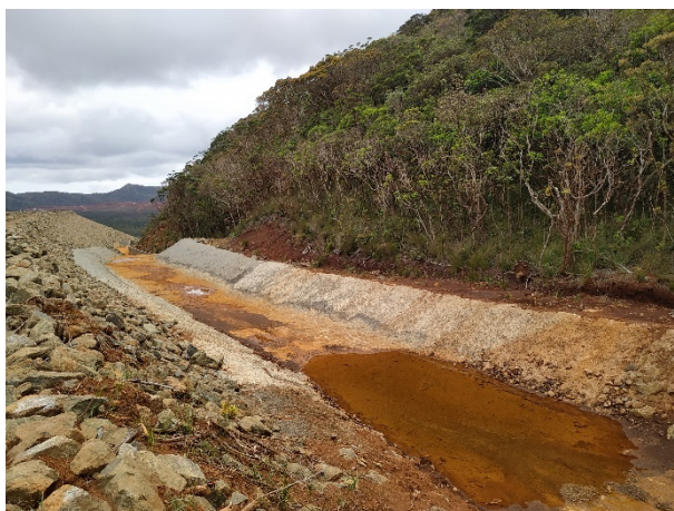
Photo 64 : vue sur le coursier en enrochement bétonné
