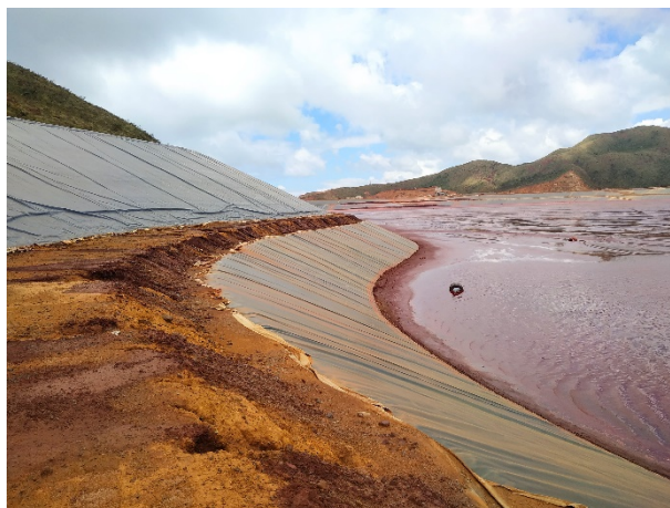
Photo 12 : Erosion du ballast de la banquette
