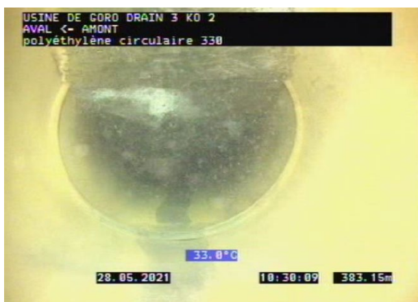
Photo 138 : Drain 3 rupture de pente
