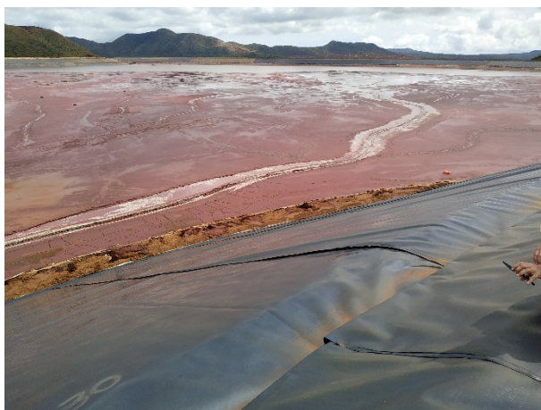
Photo 20 : Défaut d'étanchéité/ soudure de la géomembrane
