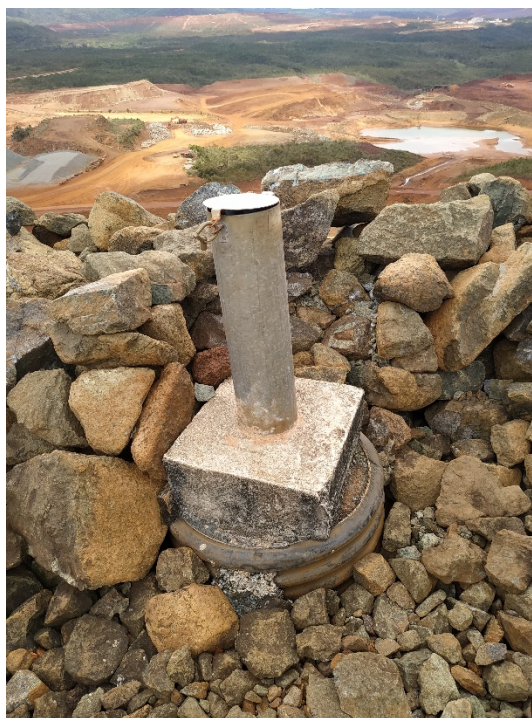
Photo 127 : Piézomètre sur la crête
