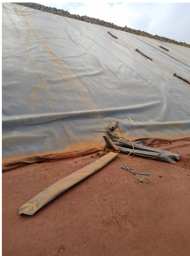
Photo 30 : Ballast tubes décrochés de la crête
