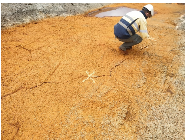
Photo 65 : Fissures dans le coursier en enrochement bétonné
