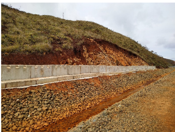
Photo 71 : vue sur un des parements passifs en bloc béton en « L » le long du drain de dérivation sud et éboulement
