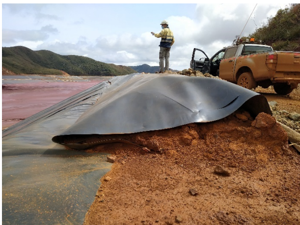
Photo 19 : Merlon de la crête protégé en géotextile et géomembrane
