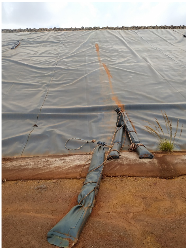
Photo 29 : Ballast tubes décrochés de la crête
