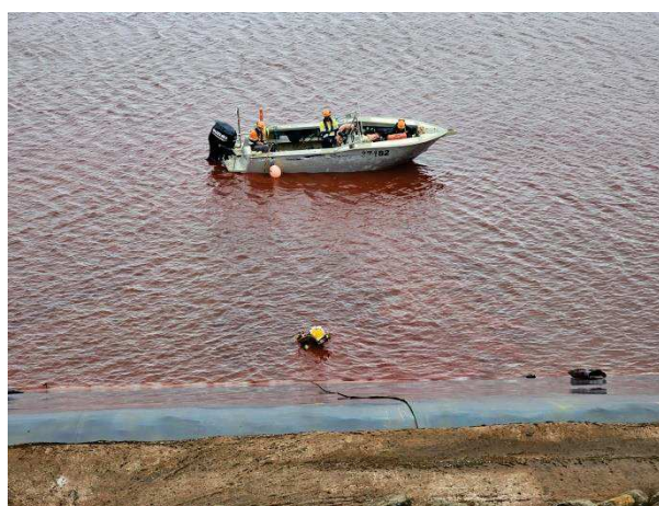
Figure 15 : vérification de l'état de liner entre les repères 500 et 850
