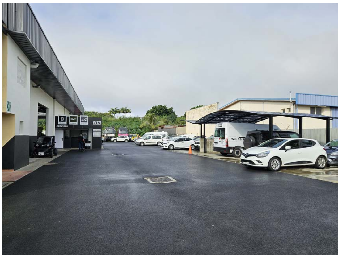
Illustration 5: Photo n°2 - vue générale de la cours extérieure
