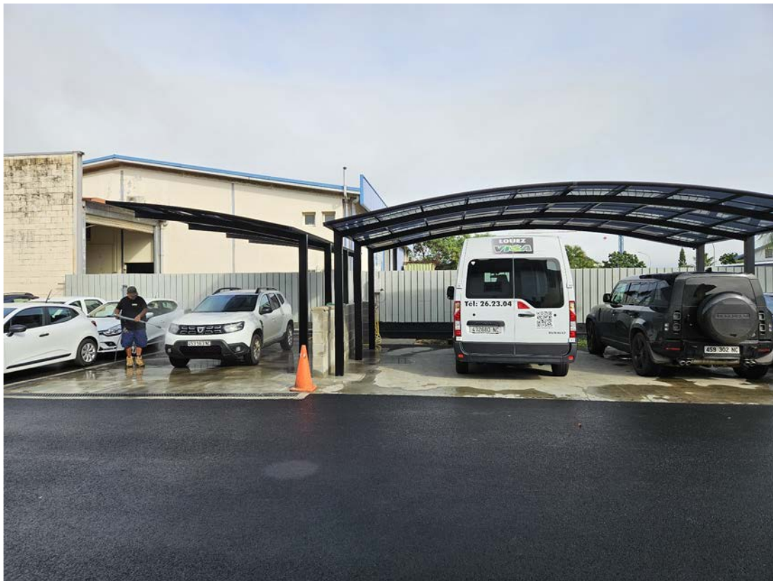
Illustration 6: Photo n°3 - Aire de lavage
