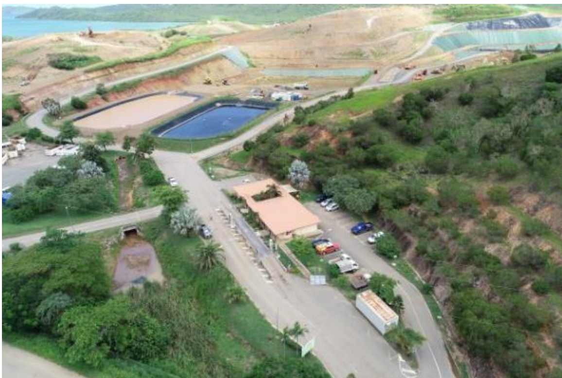
Figure 4: Vue de la bascule
