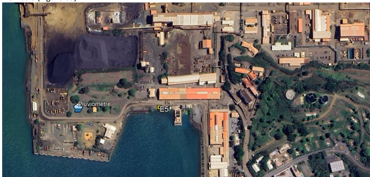
Figure 69 : position du pluviomètre du site de Doniambo
