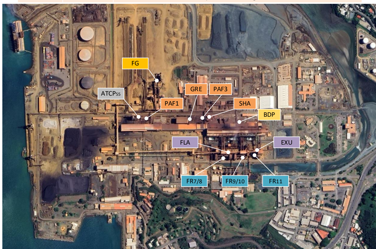
Figure 110 : Implantation des cheminées entrant dans le cadre de l'autosurveillance continue comme définie par l'arrêté n°11387-2009-ARR-DIMENC du 12 novembre 2009 relatif à l'exploitation de l'usine de Doniambo.
